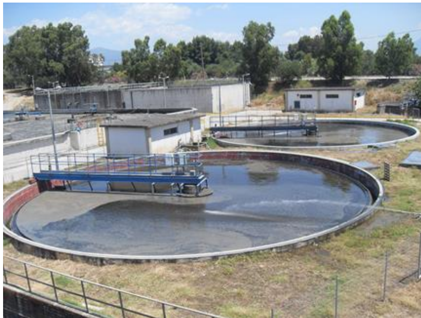
1-7 Κυκλική δεξαμενή καθίζησης (Hellas Environment, Βι.Πε Πάτρας)
