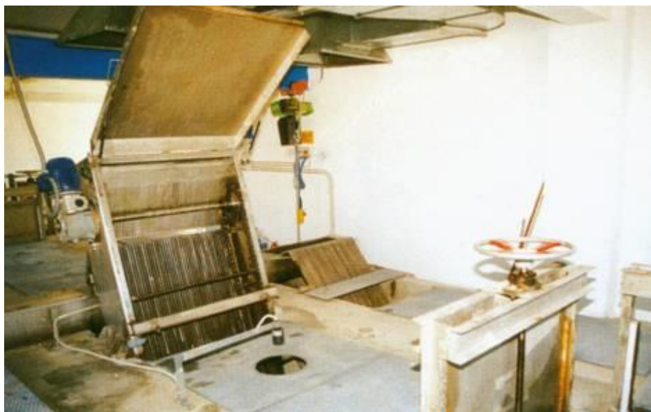
1-6 Τυπική διάταξη μηχανικής εσχάρωσης (ΔΕΥΑ Λέσβου)
