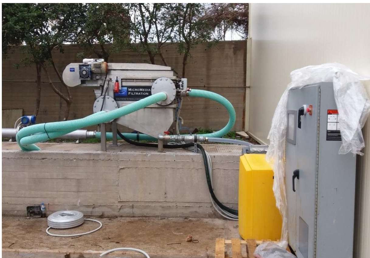
5-1 Η εγκατάσταση του μικροκόσκινου πάνω από το τσιμεντένιο κανάλι εξόδου της εξάμμωσης στην ΕΕΛ Ρεθύμνου
