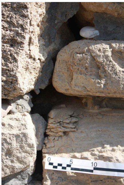
Εικόνα 10 και Εικόνα 11: Αριστερά, διαβρωμένο τσιμεντοκονίαμα στη θέση δειγματοληψίας του λίθου ΚΜ28Λ. Παρατηρείστε το μεγάλο κενό που έχει προκύψει λόγω κονιοποίησης του αυθεντικού κονιάματος δομής καθώς και τον κατακερματισμό του λίθου. Δεξιά, αρμολόγημα με τσιμεντοκονίαμα παρόμοιο με το ΚΜ19R. Παρατηρείστε τις διάφορες ρωγμές που έχουν προκληθεί στους λίθους, και, λόγω της μηχανικής ασυμβατότητας των υλικών.
