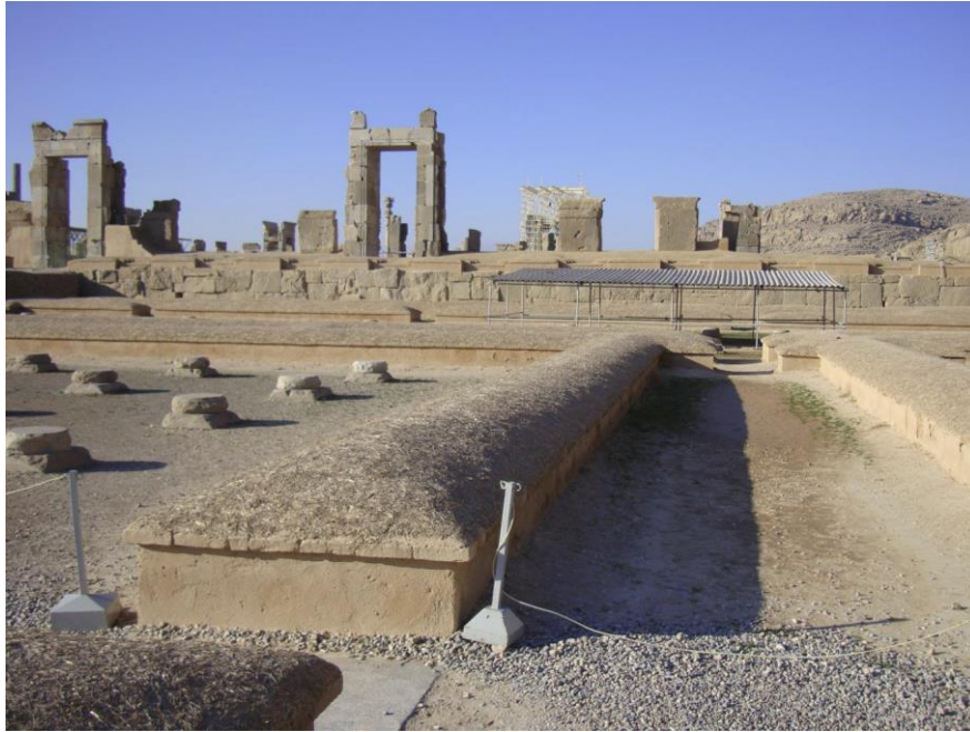
Εικόνα 9: Επίστεψη τοιχοποιίας σε αρχαιολογικό χώρο στο Ιράν. (Μαραβελάκη Π. , 2013-14)
