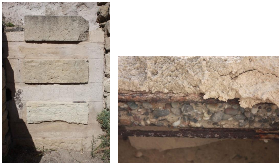
Εικόνα 7 και Εικόνα 8: Αριστερά, η υπόμνηση ξύλου ως ξυλοδεσιάς σε τμήμα της τοιχοποιίας. Δεξιά, διαβρωμένη δοκός οπλισμένου σκυροδέματος, με οξειδωμένο οπλισμό και παρουσία θαλάσσιων βότσαλων ως αδρανές. (αρχείο του εργαστηρίου)
