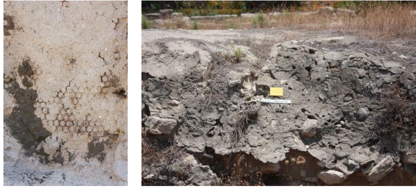
Εικόνα 5 και Εικόνα 6: Αριστερά η νεότερη επίταση εφαρμοσμένη επάνω σε συρμάτινο πλέγμα. Δεξιά η παλαιότερη επίταση με σκούρο τσιμεντοκονίαμα σε χείριστη κατάσταση διατήρησης. (αρχείο του εργαστηρίου)
