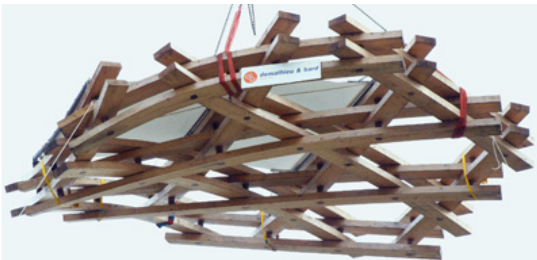
Εικόνα 33: Κατασκευαστική λεπτομέρεια του κελύφους.
