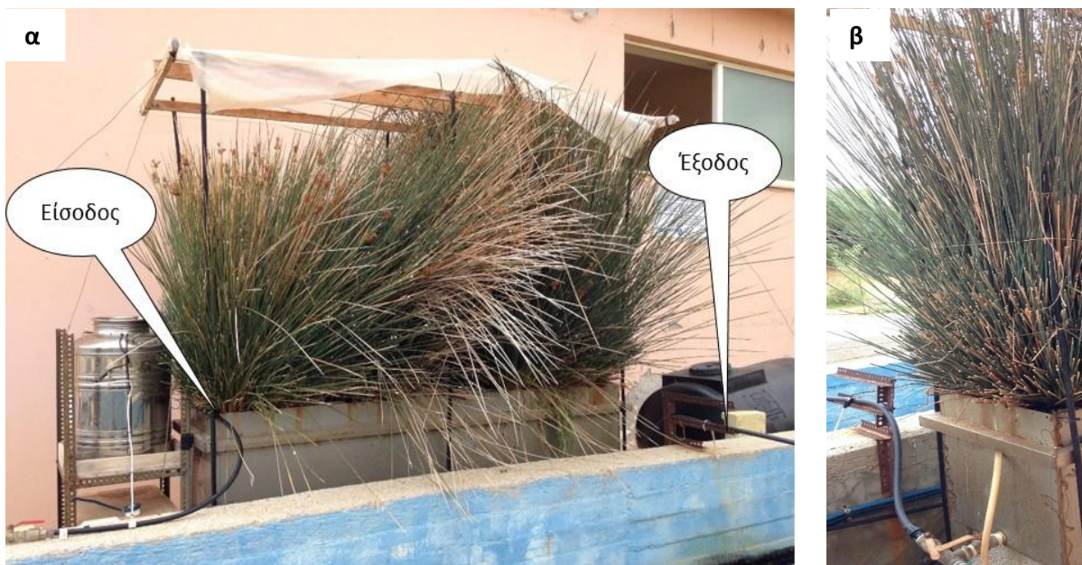
Εικόνα 6: (α) Παρουσίαση εισόδου και εξόδου στον Υγροβιότοπο με Juncus acutus στην εγκατάσταση επεξεργασίας λυμάτων της πόλης των Χανίων και (β) Παρουσίαση εξόδου στον Υγροβιότοπο με Juncus acutus στην εγκατάσταση επεξεργασίας λυμάτων της πόλης των Χανίων.
