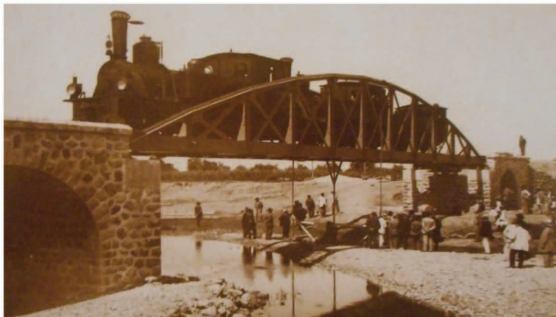
Εικ. 11 Δοκιμή αντοχής της σιδερένιας γέφυρας του ποταμού Νέδωνα, στη γραμμή Πύργου-Κυπαρισσίας, το 1902.
