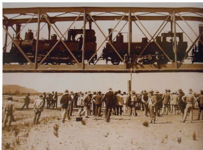
Εικ. 12 Ομοίως δοκιμή αντοχής της σιδερένιας γέφυρας του ποταμού Αλφειού, το 1902. Τη δοκιμή, εκτός από τους μηχανικούς, παρακολουθούσαν και οι πολίτες.
