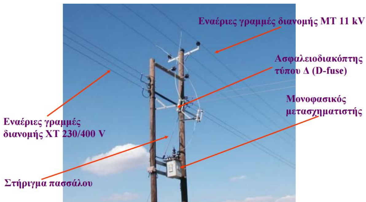
Εικόνα 1.17: Ξύλινος Στόλος γραμμών μεταφοράς
