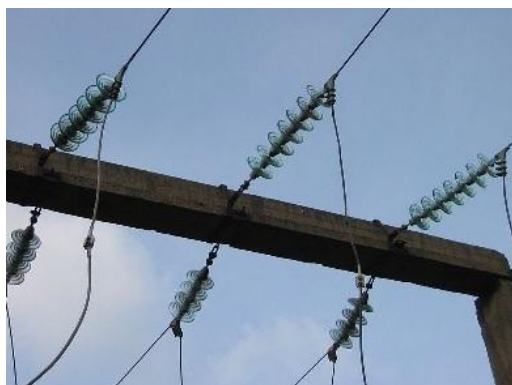
Εικόνα 1.14: Μονωτήρες γραμμών μεταφοράς
