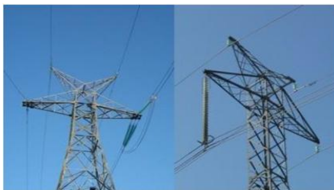
Εικόνα 1.15: Μονωτήρες πάνω σε στύλους
