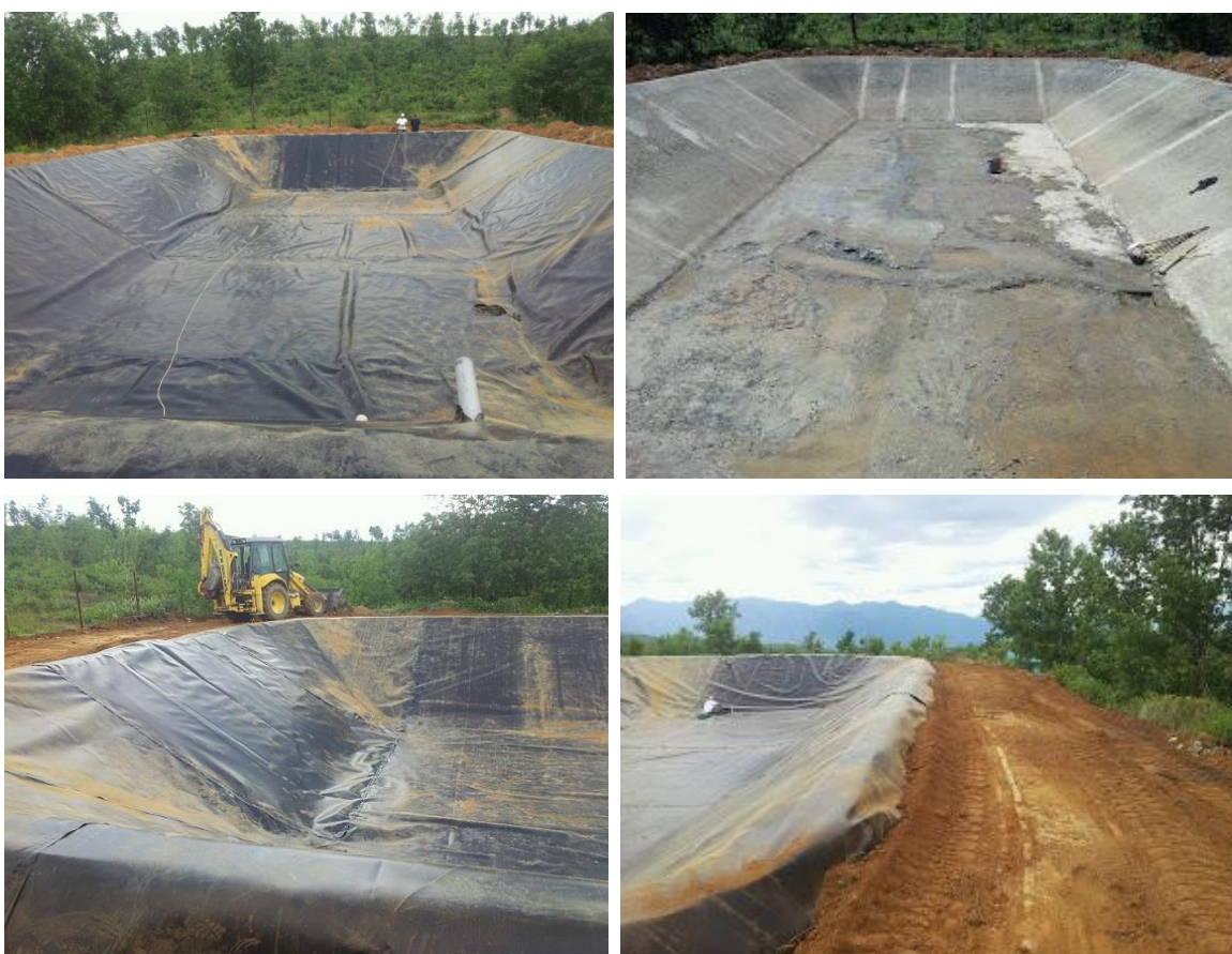
Εικόνες 2.1: Εκτεταμένες εργασίες αποκατάστασης πραγματοποιήθηκαν στη λιμνοδεξαμενή της Μαργαρίτας στο Δήμο Έδεσσας (Δήμος Έδεσσας, 2013)
