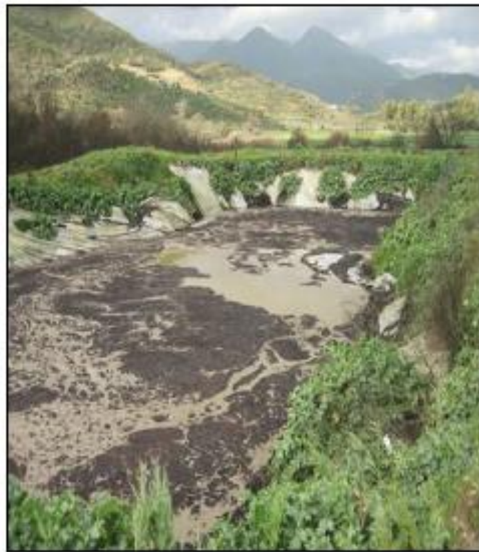
Εικόνα 3.9. Δεξαμενή σταθεροποίησης οργανικού υλικού αποβλήτων ελαιουργείου
