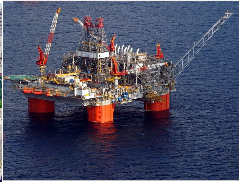
Εικόνα 3: Thunder Horse PDQ, η μεγαλύτερη υπεράκτια εγκατάσταση του είδους του στον κόσμο (semi-submersible)
