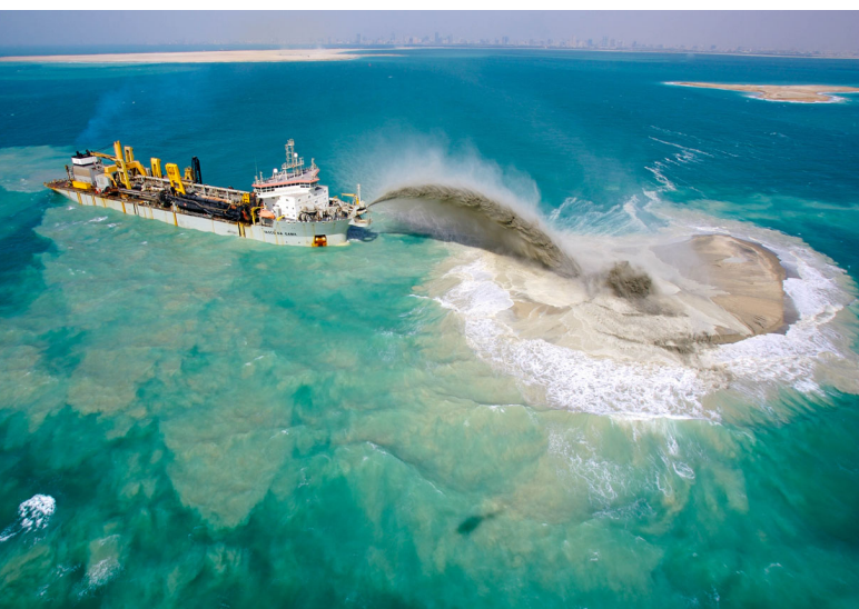
Εικόνα 5: Κατασκευή του τεχνητού νησιού Palm Deira, στο Dubai χρησιμοποιώντας άμμο από τον βυθό ( Nakheel )
