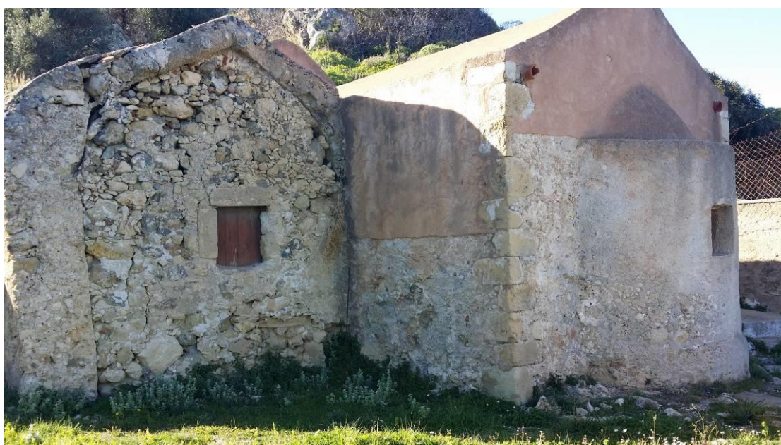
Σχήμα 55: Εξωτερική όψη του ναού με εμφανή την αποκόλληση του νότιου τοίχου του νότιου κλίτους
