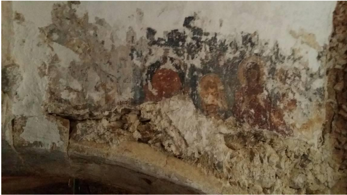
Σχήμα 56: Εσωτερική καμάρα με μερική καθίζηση και αποκολλημένα τμήματα της τοιχογραφίας
