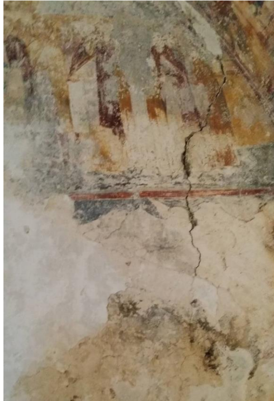
Σχήμα 57: Άποψη του δυτικού τοίχου του βόρειου κλίτους με εμφανές ρωγμές, υγρασία και αλλοιωμένες νωπογραφίες
