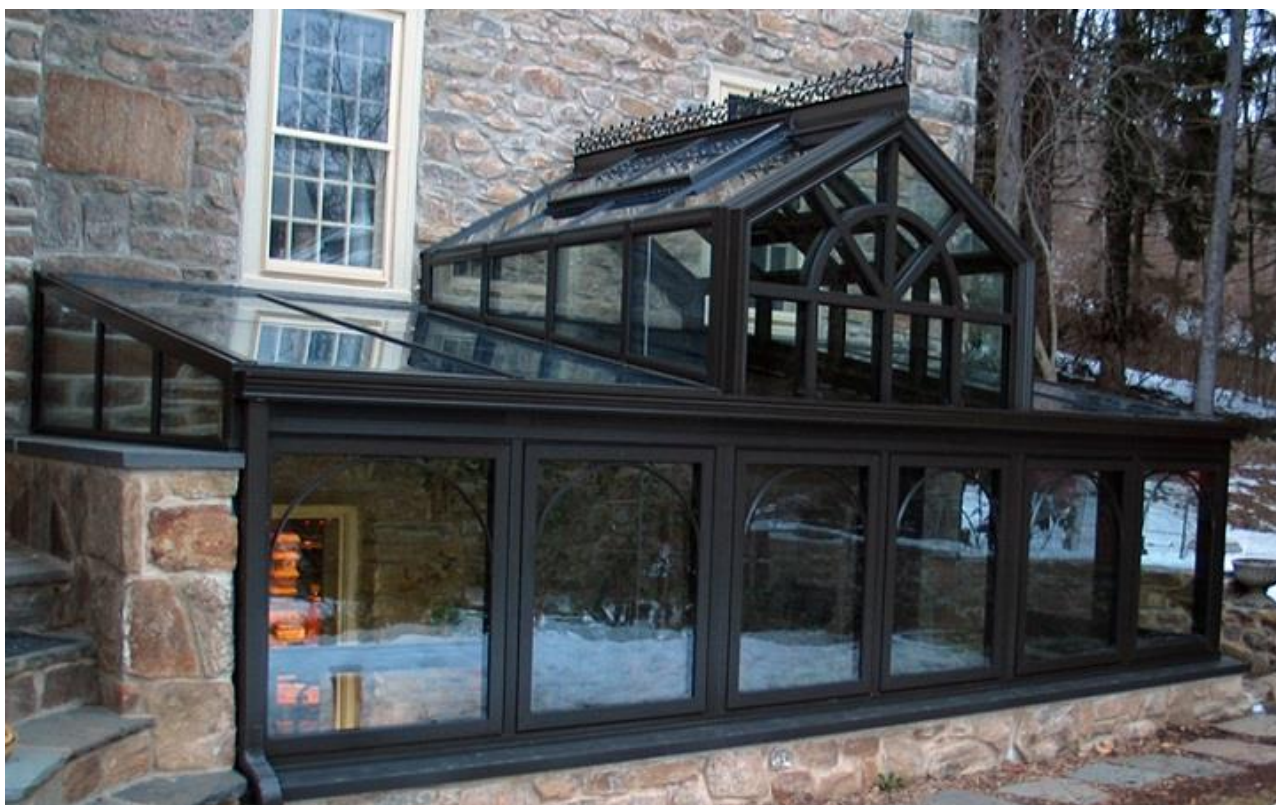
Εικ. 96: Υποβαθμισμένος ηλιακός χώρος, με φύτευση, δυνατότητα αερισμού και πέτρινο τοίχο μάζας.
