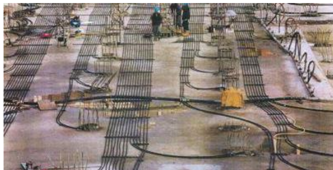
Εικ. 124: Οριζόντιο δίκτυο σε πεδίο πασσάλων-γεωεναλλακτών πριν από τη σκυροδέτηση της πλάκας, ως θερμικά ενεργό στοιχείο.
