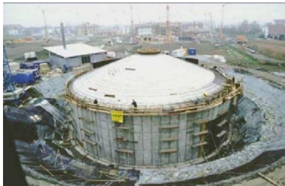
Εικ. 127: Υπόσκαφη δεξαμενή κατά την κατασκευή.
