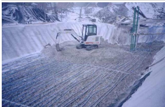
Εικ. 130: Παραδείγματα λάκκων θερμικής αποθήκευσης με σκύρα κατά την κατασκευή. Στο στάδιο αυτό είναι εμφανείς οι διαστρώσεις των σωληνώσεων.
