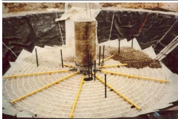
Εικ. 130: Παραδείγματα λάκκων θερμικής αποθήκευσης με σκύρα κατά την κατασκευή. Στο στάδιο αυτό είναι εμφανείς οι διαστρώσεις των σωληνώσεων.
