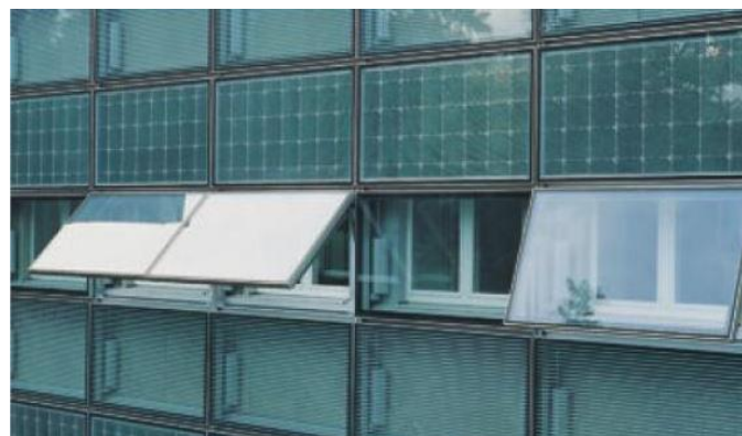
Εικ. 67: Κτήριο SUVA, Basel, 1993, Herzog & de Meuron. Οι μεμβράνες των υαλοπινάκων τοποθετήθηκαν κατά την αναβάθμιση του κτηρίου και επιτελούν πολλαπλές λειτουργίες.
