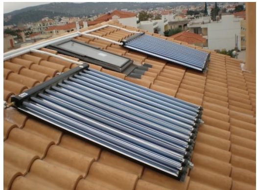
Εικ. 98: Τοποθέτηση ηλιακών συλλεκτών κενού σε στέγη κτιρίου
