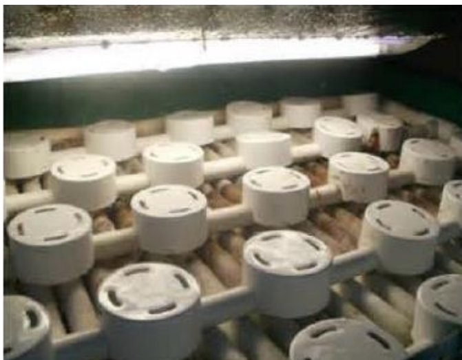
Εικόνα 7: Βιοαντιδραστήρας AdvanTex (φαίνεται το πάνω μέρος των φύλλων του συνθετικού υφάσματος καθώς και οι αντλίες ψεκασμού του αποβλήτου. Πηγή: Babatsouli et. al. 2015
