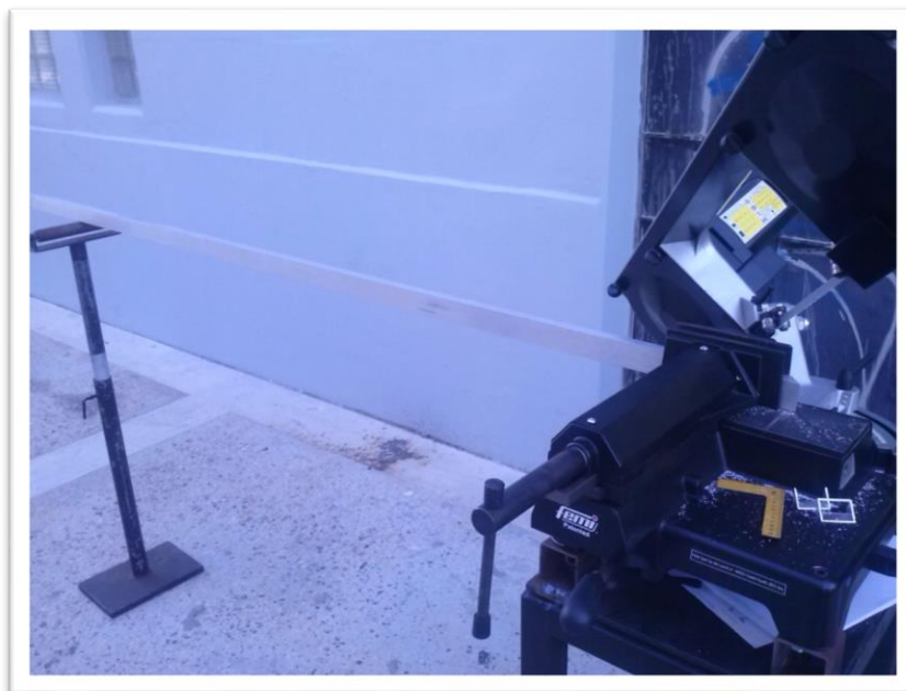
Εικόνα 5.2: Στήριξη των δοκών αλουμινίου για εύκολη και ασφαλή κοπή
