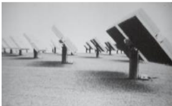
Εικόνα 2.14: Το πρώτο μεγαλύτερο εγκατεστημένο πάρκο συγκεντρωτικών φ/β συστημάτων δυναμικότητας 350 kW εν ονόματι SOLERAS, στην Σαουδική Αραβία [Luque et al., 2007]
