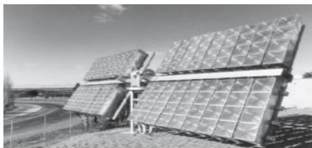
Εικόνα 2.13: Εγκατάσταση δυναμικότητας 1-kWp που αναπτύχθηκε από το Πολυτεχνείο της Μαδρίτης, στην Ισπανία το 1980 [Luque et al., 2007]
