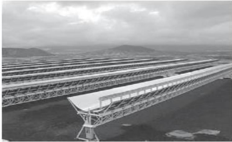
Εικόνα 2.15: Το πρωτότυπο της IES/UPM και της BP Solar με το εμπορικό όνομα EUCLIDES που εγκαταστάθηκε το 1998 στην Tenerife της Μαδρίτης [Luque et al., 2007]
