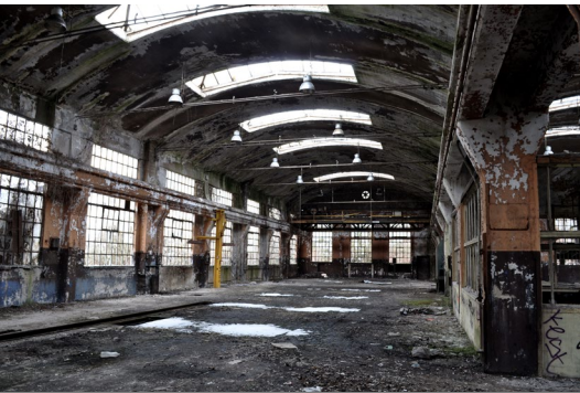
εικόνα 9 : Χωρικά χαρακτηριστικά βιομηχανικών κτιρίων | φεγγίτες
