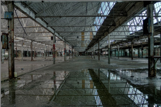
εικόνα 8: Χωρικά χαρακτηριστικά βιομηχανικών κτιρίων | στατικό σύστημα και φεγγίτες
