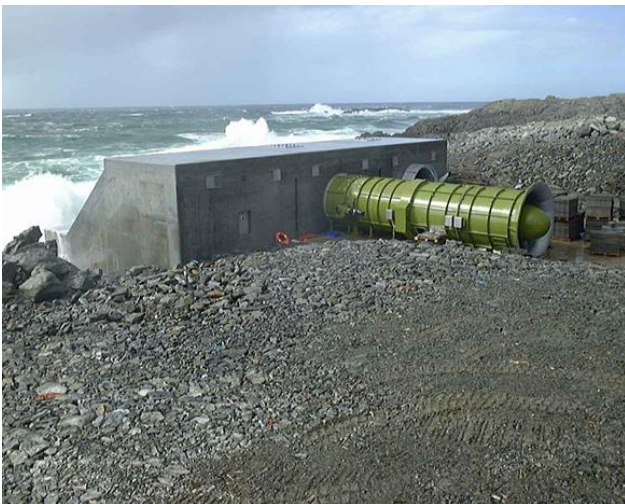
Εικόνα 2: Εγκατάσταση της LIMPET υδάτινης παλλόμενης στήλης στην περιοχή Isle της Wagen Islay[31]
