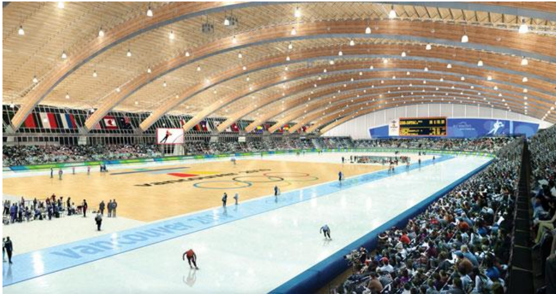
Εικόνα 12: Στάδιο ice-skating, Richmond Olympic Oval, τοξωτά δοκάρια μήκους 100m, Καναδάς.
