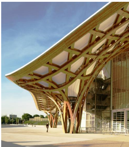
Εικόνα 13: Ξύλινη κατασκευή περίπλοκης γεωμετρίας, Center Pompidou-Metz, Γαλλία.
