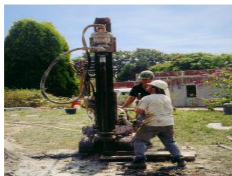
Εικόνα 1.24 Η διάνοιξη της γεώτρησης με το γεωτρήπανο. [3]
