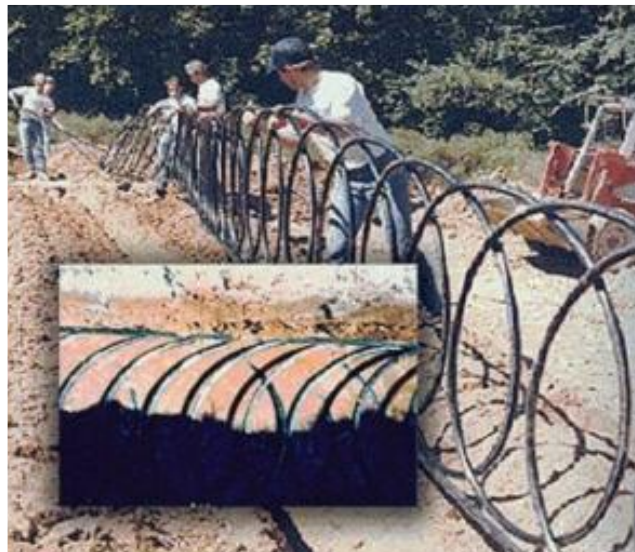
Εικόνα 1.23β Εγκατάσταση σπειροειδούς οριζόντιου γεωθερμικού συστήματος. [3]
