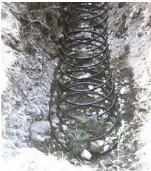
Εικόνα 1.23α Σπειροειδής διάταξη οριζόντιου γεωθερμικού συστήματος. [3]
