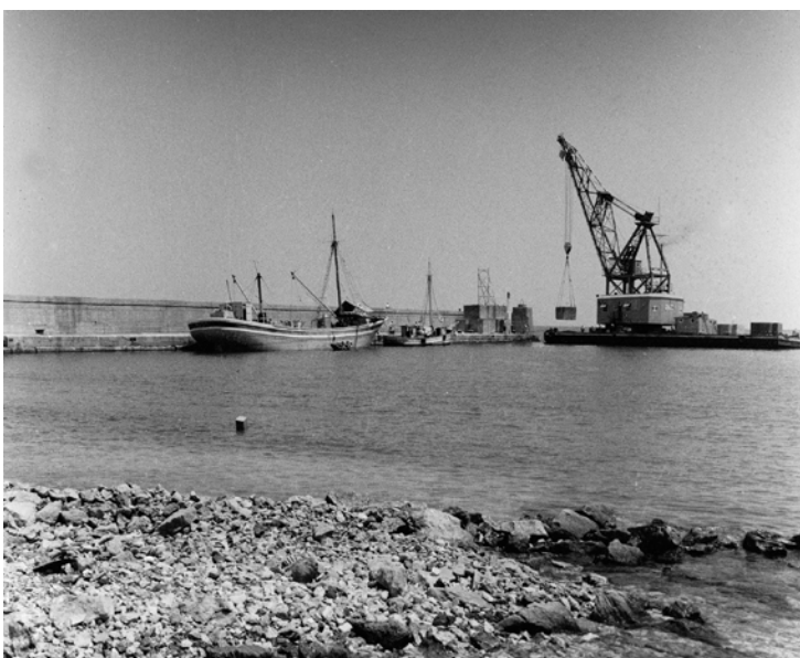
Εικόνα 153. Τοποθέτηση ογκόλιθων στο κρηπίδωμα (1960)
