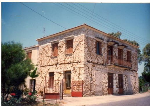
Φωτογρ. 1 : Διόροφο λιθόκτιστο κτήριο με χαρακτηριστικές ρωγμές στις τοιχοποιίες από το σεισμό.
