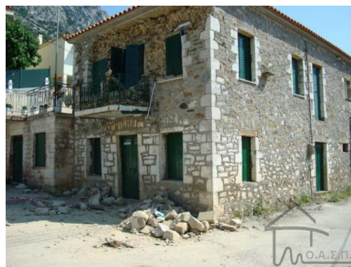
Φωτογρ. 2 : Βλάβες σε κτήριο από φέρουσα τοιχοποιία
