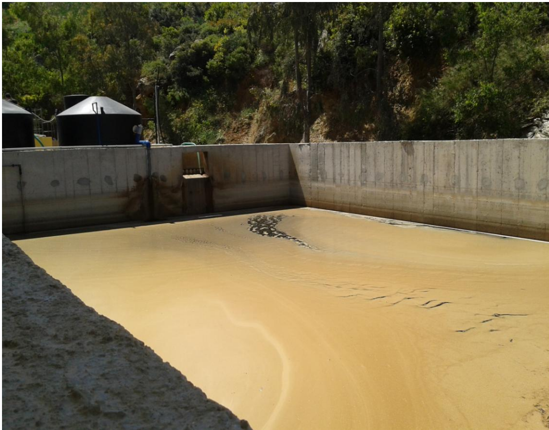
Εικόνα 3.2.1 : Δεξαμενή εξισορρόπησης
