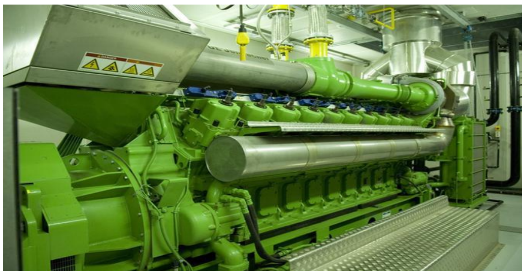
Εικόνα 1.2.2.2 : Μηχανή εσωτερικής καύσης βιοαερίου
