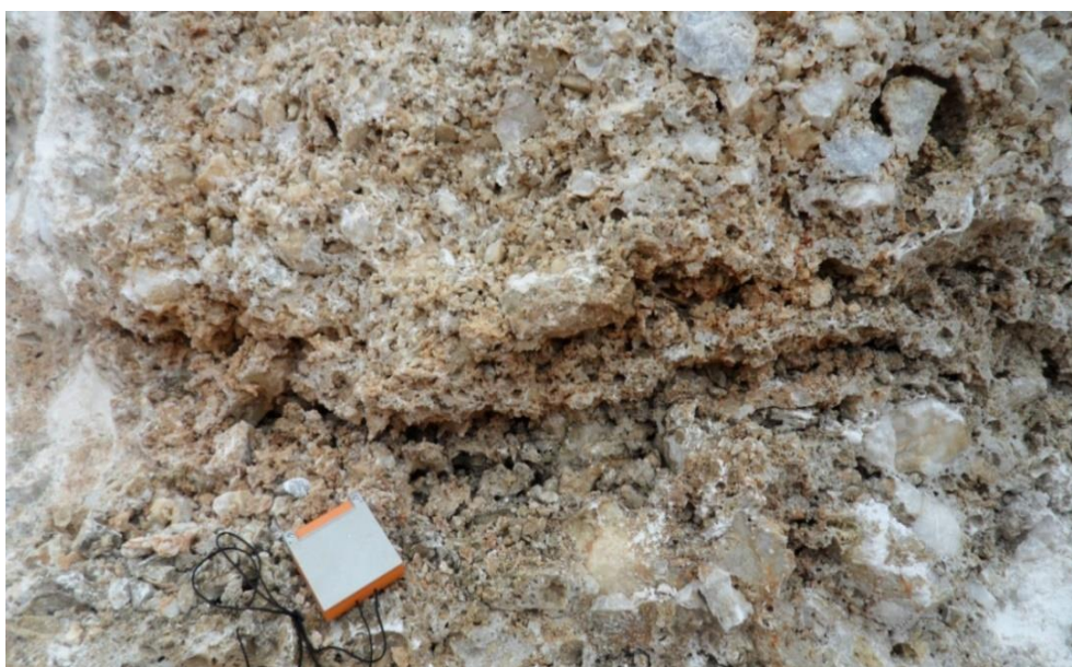
Εικόνα 10: Διάφορες μορφές καρστικών εγκοίλων στα τεχνητά πρανή του χώρου της ανατολικής επέκτασης.
