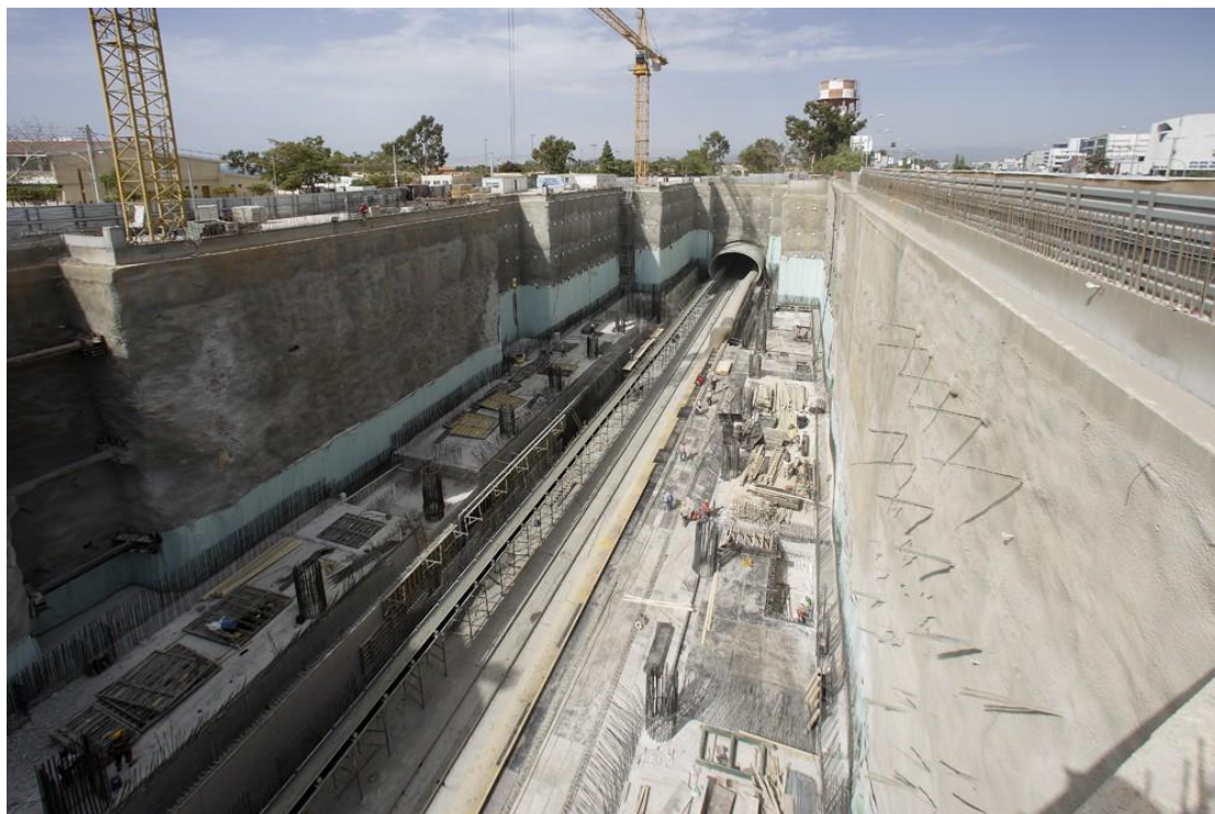
Σχήμα 2-5: Μέθοδος Ανοιχτού Ορύγματος ( Cut and Cover) - Επέκταση προς Ελληνικό – (Αττικό Μετρό,2011)
