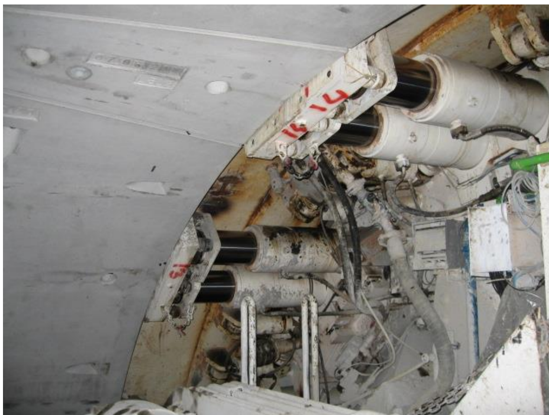
Σχήμα 3-11: Πέδιλα έδρασης των εμβόλων ώθησης του TBM στο δακτύλιο της μόνιμης επένδυσης (Αττικό Μετρό, 2011)
