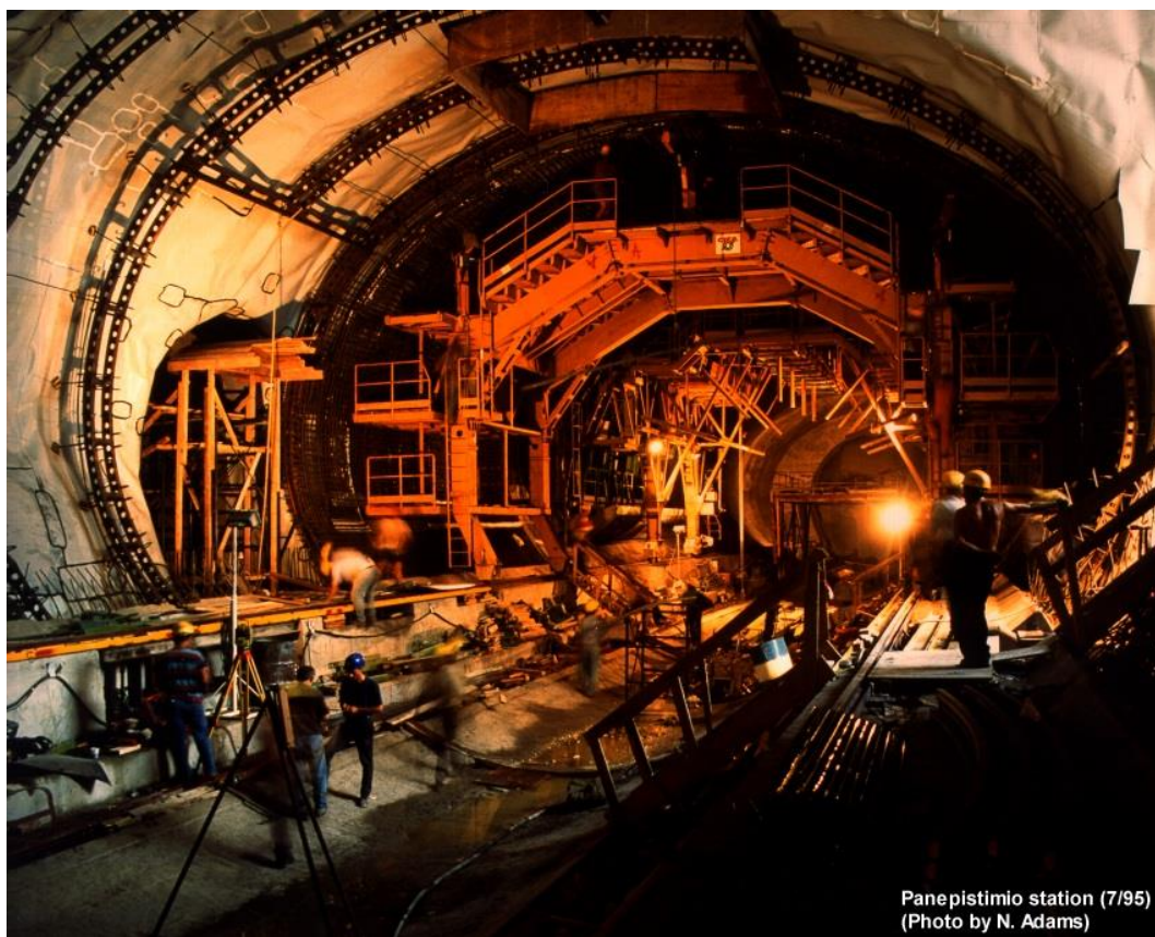
Σχήμα 2-4: Συμβατική μέθοδος εκσκαφής σπηραγγων (NATM) – (Αττικό Μετρό, 2011)
