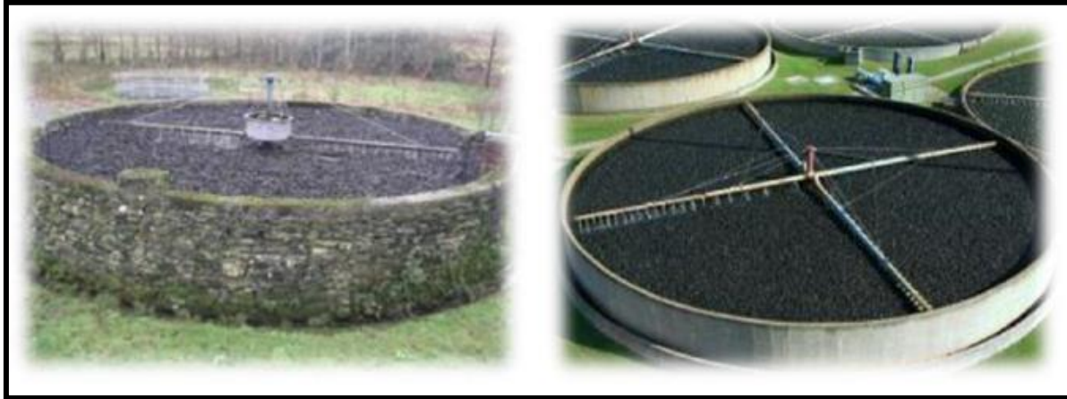
Εικόνα 9, Εγκαταστάσεις σταλακτικών φίλτρων. [ Igreenion , 2014]
