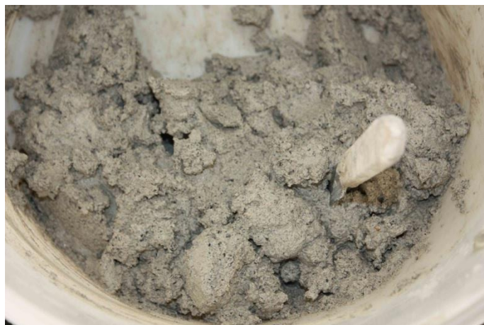
Σχήμα 144: Ανάμιξη του κονιάματος.
