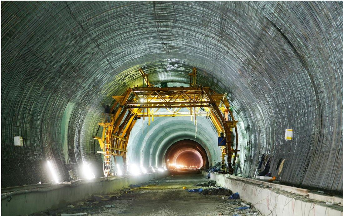
Εικόνα 2: Χρήση κινητής πλατφόρμας για τις εργασίες τοποθέτησης οπλισμού
