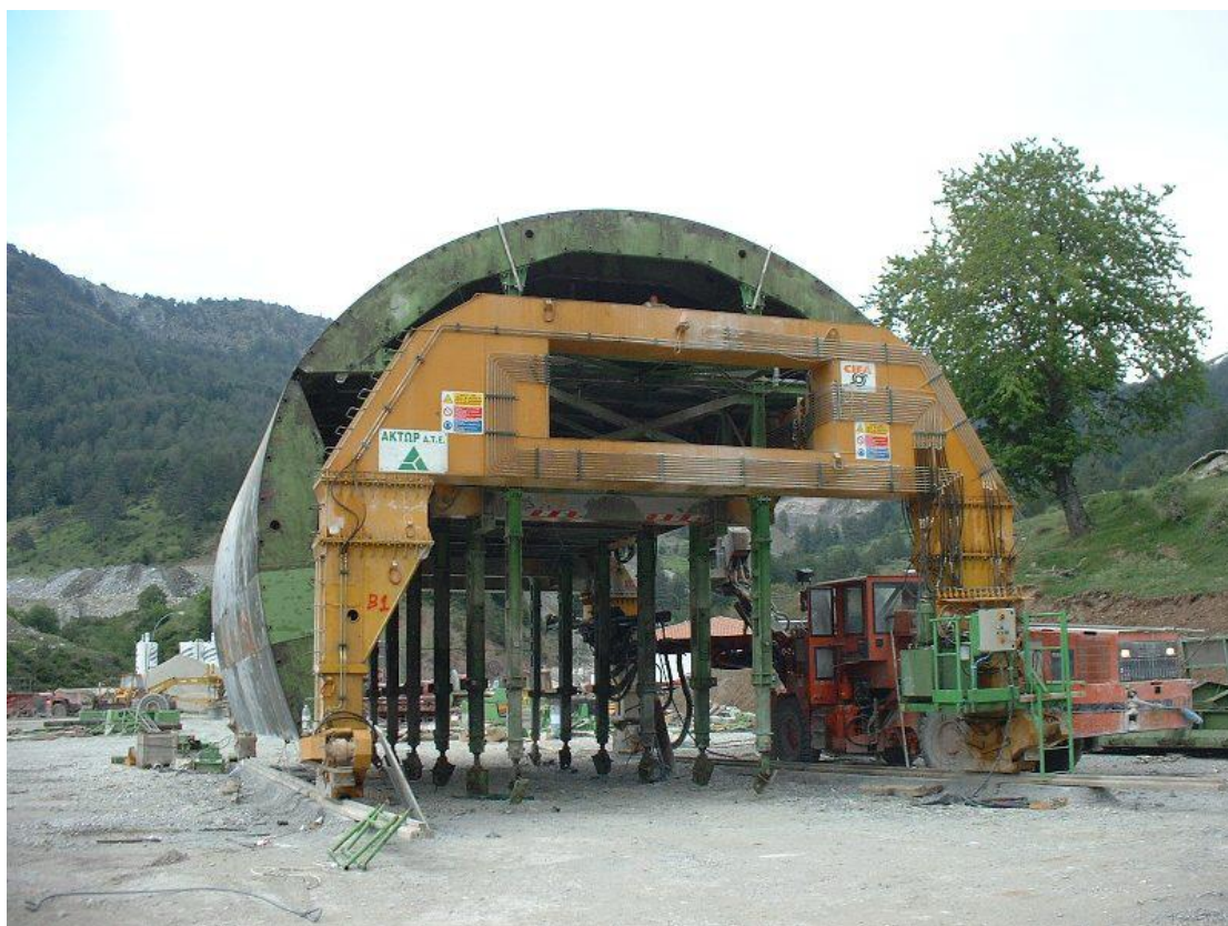
Εικόνα 3: Συναρμολόγηση και κατασκευή του μεταλλότυπου σκυροδέτησης της μόνιμης επένδυσης
