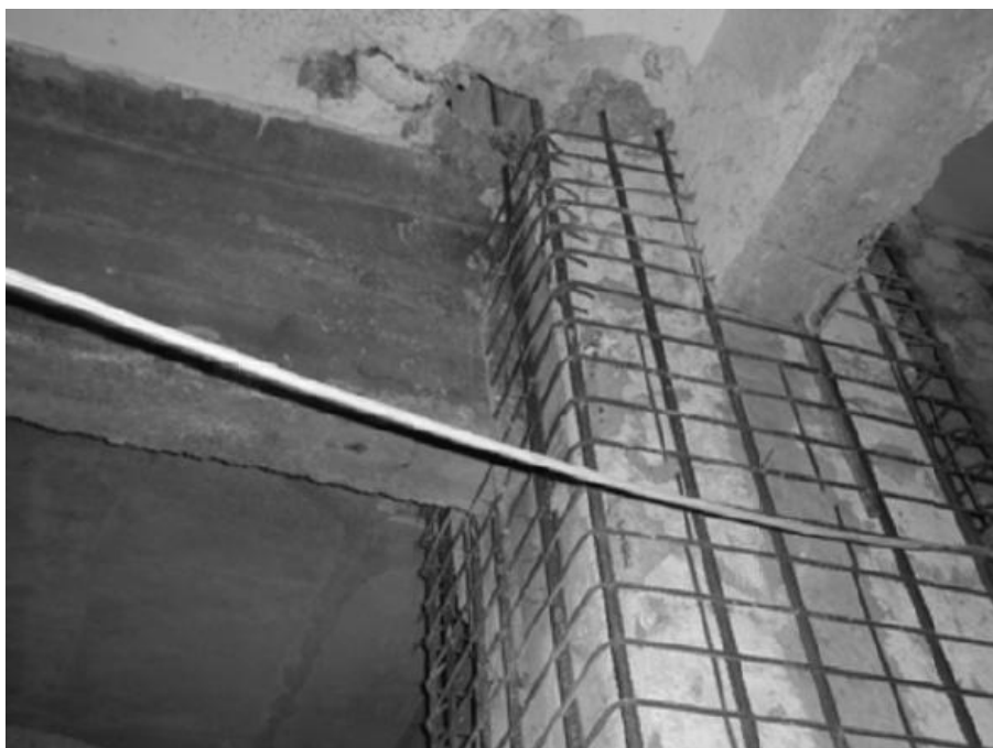
Εικόνα 2.10: Ενίσχυση στην περιοχή κόμβου δοκού-υποστυλώματος.
