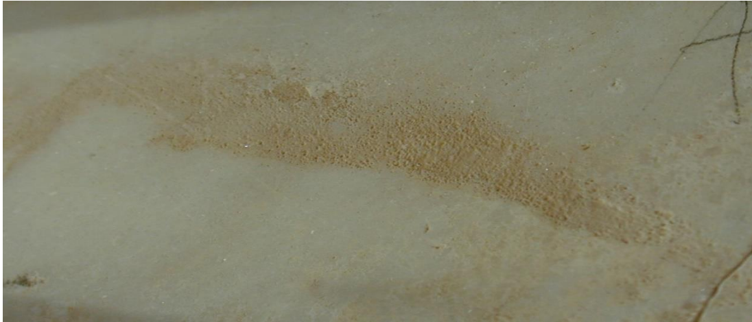
Εικόνα 18: Κυψελοειδής διάβρωση μαρμάρου
