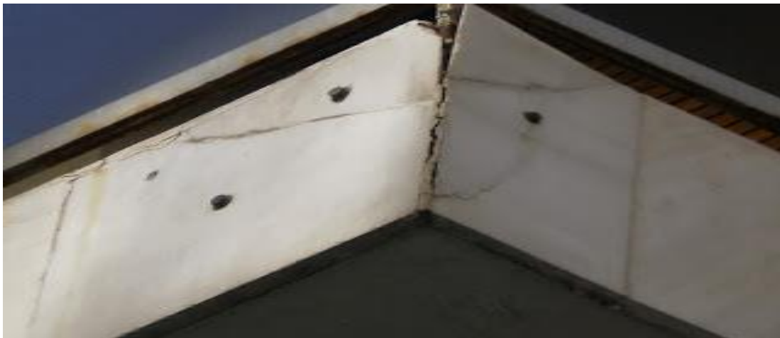
Εικόνα 22: Φθορά μαρμάρου από θραύσεις
