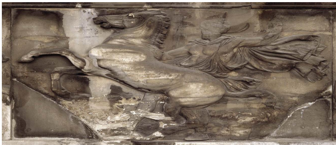
Εικόνα 21: Φθορά μαρμάρου από επικαθίσεις αιωρούμενων σωματιδίων
