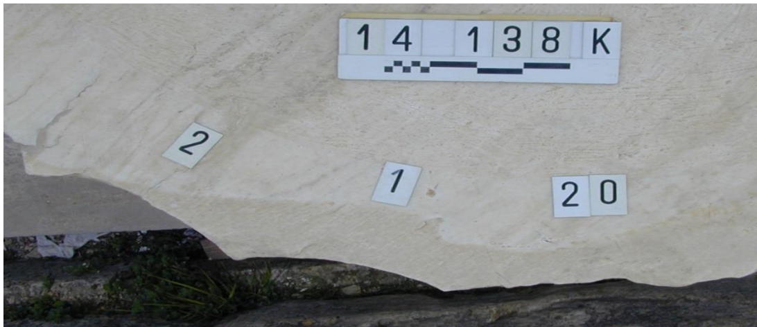
Εικόνα 20: Περικρυσταλλική φθορά μαρμάρου
