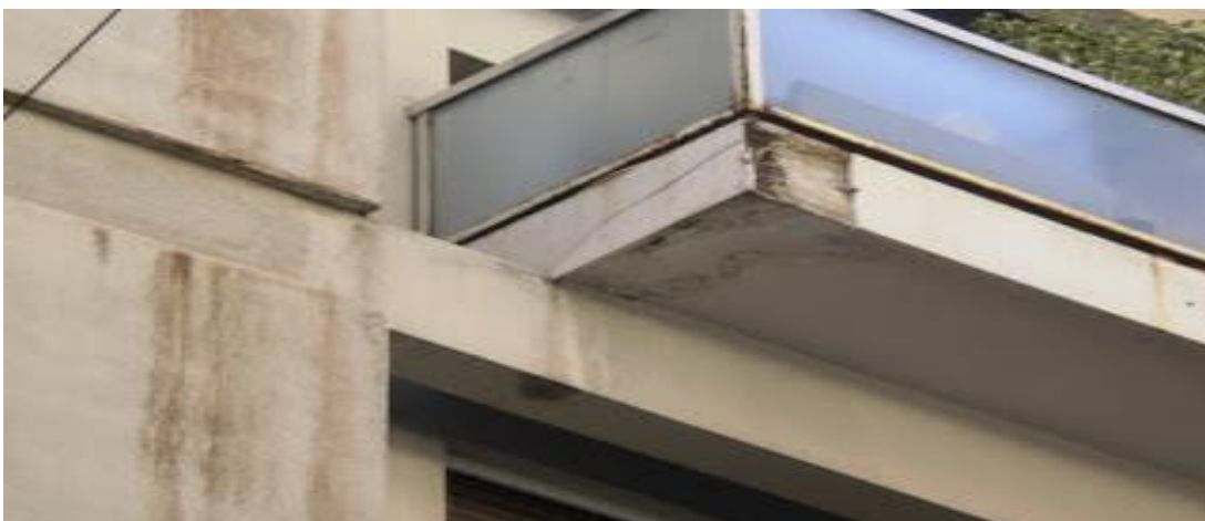
Εικόνα 23: Φθορά μαρμάρου από υγρασία
