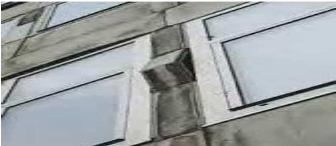
Εικόνα 25: Φθορά μαρμάρου μετά από κύρτωση
