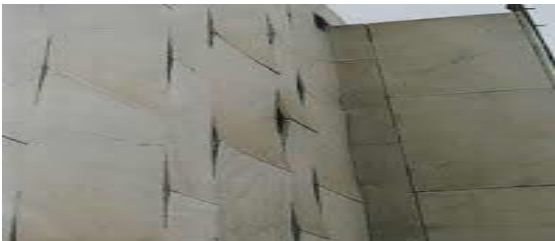
Εικόνα 26: Φθορά μαρμάρου μετά από κύρτωση
