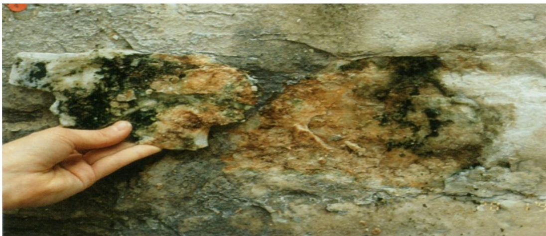
Εικόνα 19: Βιολογική φθορά μαρμάρου
