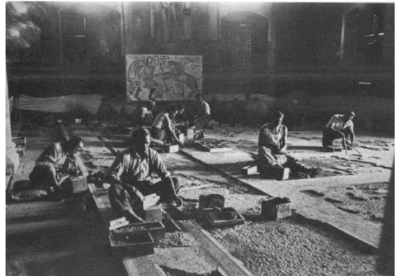
Εικ. 114. Η μνημειώδης εσωτερική σκάλα ανόδου στον όροφο (αριστερά), άποψη της εσωτερικής αυλής του Παλατιού μετά την διαμόρφωση (κεντρικά) και φωτογραφία από τις εργασίες τοποθέτησης και αποκατάστασης των ψηφιδωτών δαπέδων από την Κω στις αίθουσες του Παλατιού του Μεγάλου Μαγίστρου (δεξιά)
