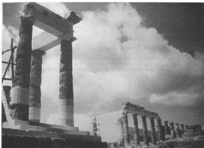
Εικ. 127. Κατά τη διάρκεια εργασιών αναστήλωσης της Στοάς της Ακρόπολης της Λίνδου (αριστερά) και μετά τις εργασίες επέμβασης (δεξιά)
