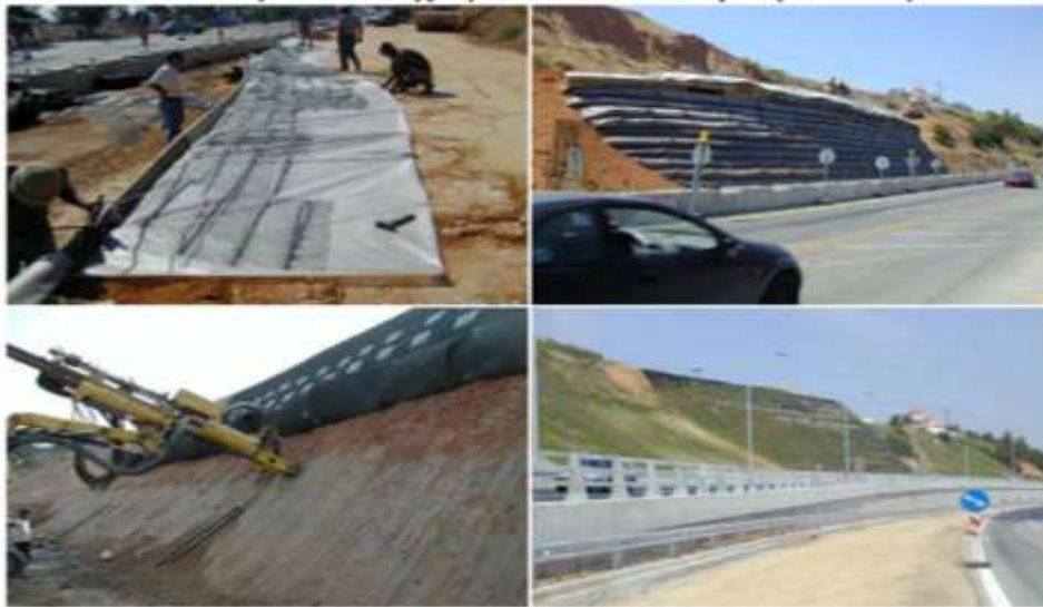
Σχήμα 2.13. Διάφορες φάσεις της κατασκευής του οπλισμένου επιχώματος κατά την κατασκευή του και κατά τη λειτουργία του (Geognosi , 2015).
