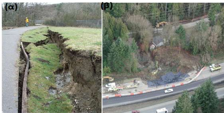
Σχήμα 2.31. Αστοχία επιχώματος στο Capitol Interpretive Center (α) και το εδαφικό υλικό που αστόχησε και μετακινήθηκε κατά 150m και κάλυψε το δρόμο (β) (Bray et al., 2001).
