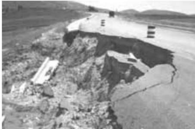
Σχήμα 2.32. Αστοχία οδικού επιχώματος και πρανούς, (Parazachos et al., 1997).
