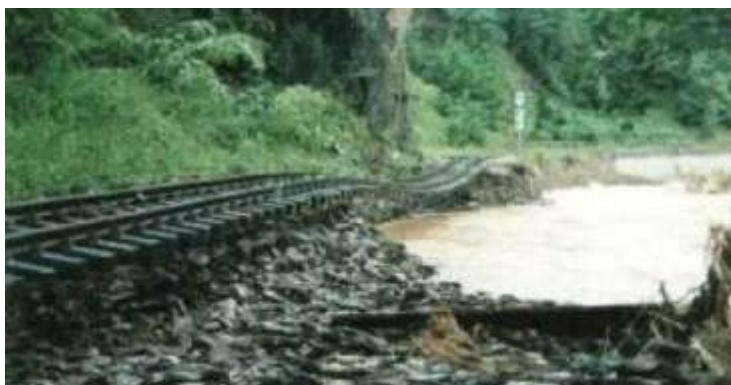
Σχήμα 2.4. Απεικόνιση περίπτωσης καθίζησης λόγω βαλτωδών εδαφών και καταστροφή της σιδηροδρομικής γραμμής.
