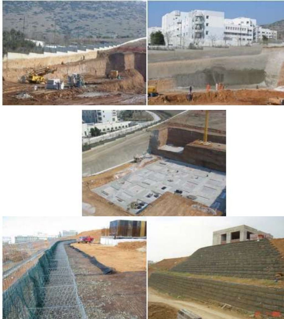
Σχήμα 2.12. Όψεις του οπλισμένου πρανούς κατά την κατασκευή και κατά τη λειτουργία του (Geognosi , 2015).
