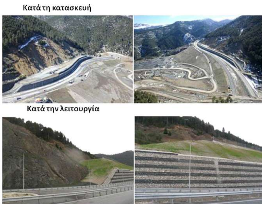
Σχήμα 2.11. Δυο φάσεις του οπλισμένου επιχώματος, κατά την κατασκευή του και κατά τη λειτουργία του (Geognosi , 2015).
