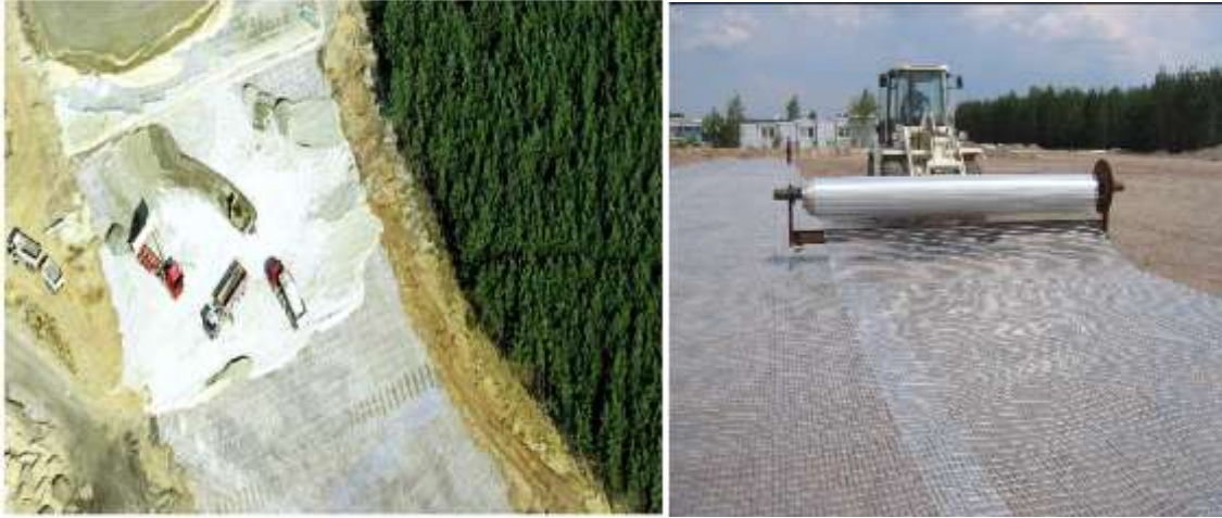
Σχήμα 2.5. Πανοραμική απεικόνιση της τοποθεσίας του έργου οδοποιίας και εφαρμογή των γεωσυνθετικών.
