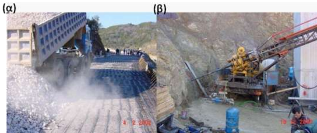
Σχήμα 2.8. Κατασκευή οπλισμένης γης (α) και απεικόνιση εργασιών τοποθέτησης αγκυρών (β) (Τεχνικά Χρονικά, 2004).
