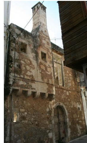
Εικ.144 Οδός Μίνωος, προεξοχή κατασκευής τζακιού και καμινάδας
