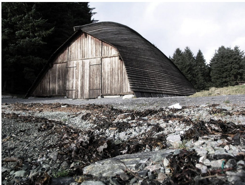
Εικ.44. Ανακατασκευή καλύβας των Βίκινγκ, όπου η κατασκευή του κελύφους αποτελεί δάνειο από την ναυπηγική τέχνη .
