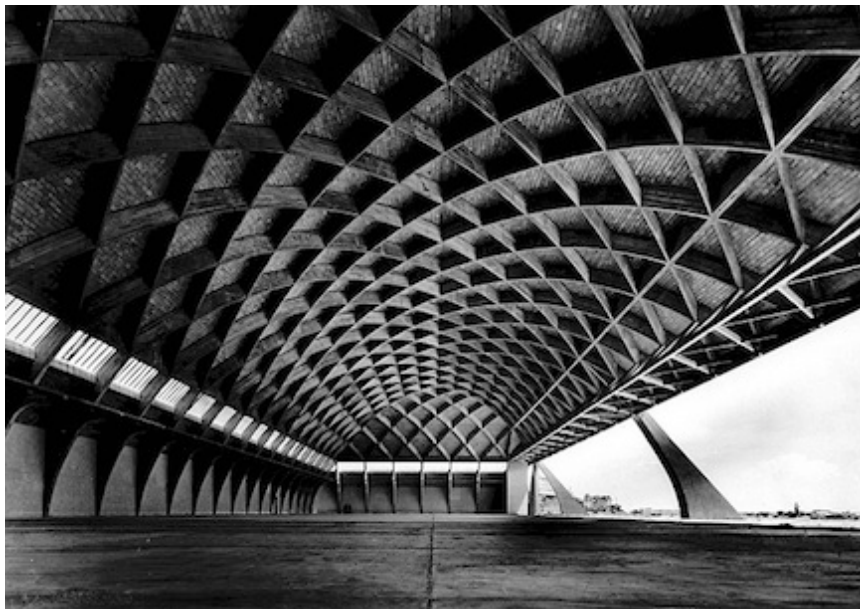
Εικ.51. Υπόστεγο παρά τη Ρώμη με στέγη τύπου Lamella από μπετόν- αρμέ. Μηχαν. Nervi. Ολοκληρώθηκε το 1938 και καταστράφηκε το 1944.
