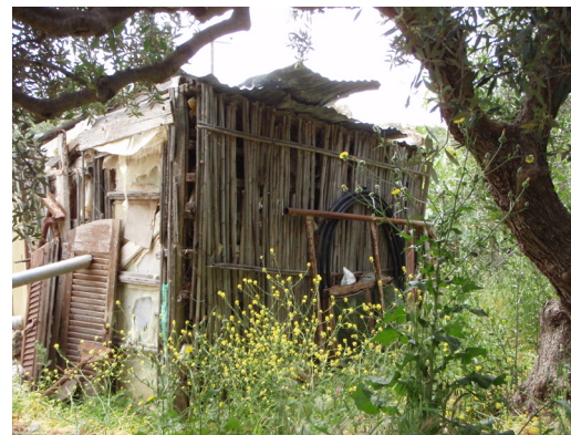
Δείγμα εφήμερης αρχιτεκτονικής. Μονόχωρη καλύβα - αποθηκευτικός χώρος με επικάλυψη από καλάμια, Πυλαγιάδα, Μακρύς Γιάλος.
