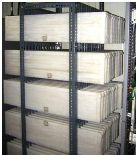
Εικόνα 2: Α Χρήση ΥΑΦ για ψύξη ηλεκτρονικών server [Finoric LLC, 2010]
