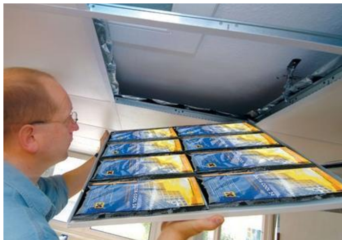
Εικόνα 1: Τοποθέτηση ΥΑΦ στην ψευδοροφή κτηρίων [Building. CO, 2012]
