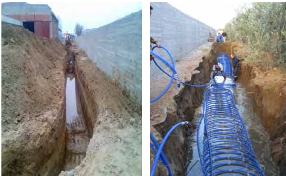
Εικόνα 2: Εκσκαφή και τοποθέτηση Slinky®
