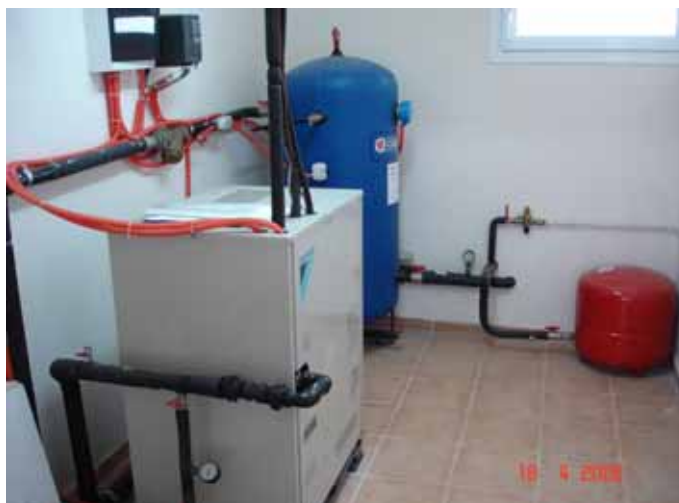
Εικόνα 1: Γεωθερμική αντλία θερμότητας VRV
