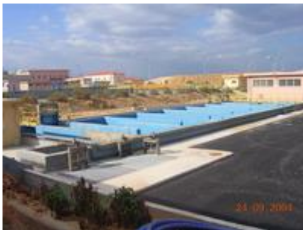
Σχήμα 2.1.9. Δεξαμενές χλωρίωσης βιολογικού καθαρισμού πόλης Χανίων.
