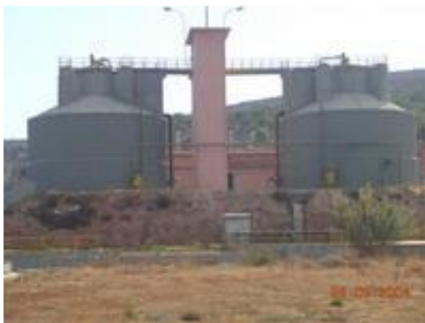
Σχήμα 2.1.12. Αναερόβιοι χωνευτές βιολογικού καθαρισμού πόλης Χανίων.
