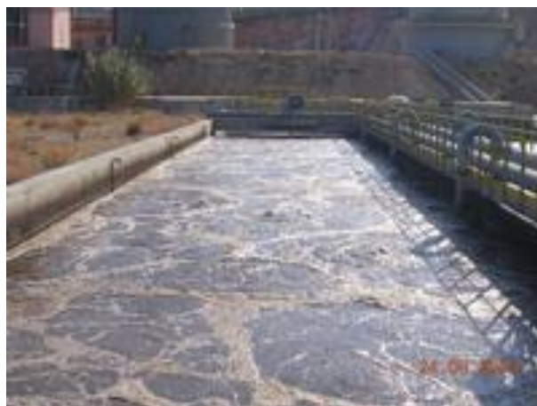
Σχήμα 2.1.7. Δεξαμενές αερισμού βιολογικού καθαρισμού πόλης Χανίων.
