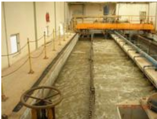
Σχήμα 2.1.4. Διατάξεις εξάμμωσης και λιποσυλλεκτών βιολογικού καθαρισμού πόλης Χανίων.
