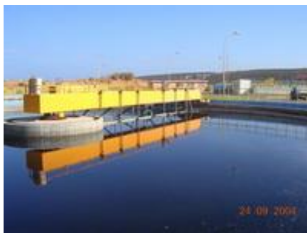
Σχήμα 2.1.8. Δεξαμενές δευτεροβάθμιας καθίζησης βιολογικού καθαρισμού πόλης Χανίων.
