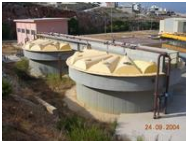
Σχήμα 2.1.11 Εγκαταστάσεις προπάχυνσης βιολογικού καθαρισμού πόλης Χανίων.
