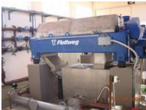
Σχήμα 2.1.10. Διάταξη μηχανικής πάχυνσης της λάσπης στο βιολογικό καθαρισμό της πόλης των Χανίων.
