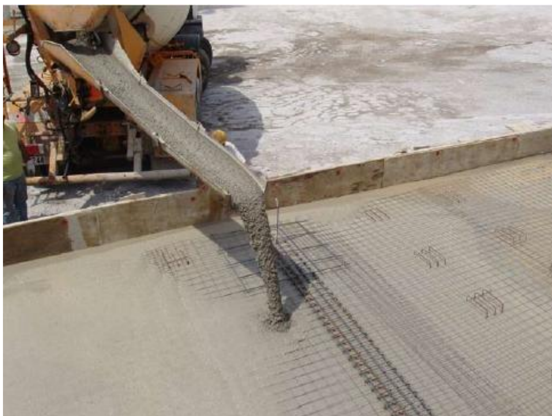
Εικόνα 2 Σκυροδέτηση πλάκας οικοδομής
