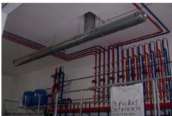
Εικόνα 5.8.: Σύστημα θέρμανσης εγκατάστασης βιοαερίου
