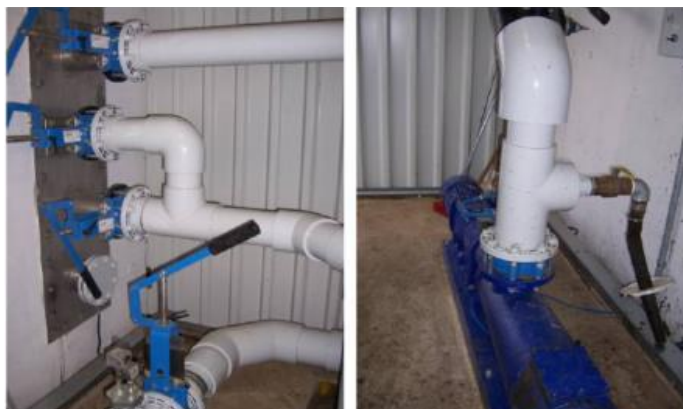
Εικόνα 5.6.: Αριστερά εικονίζονται βαλβίδες διακοπής και δεξιά το σύστημα άντλησης
