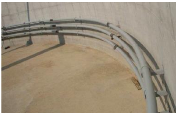
Εικόνα 5.9.: Σωληνώσεις θέρμανσης μέσα στο χωνευτήρα
