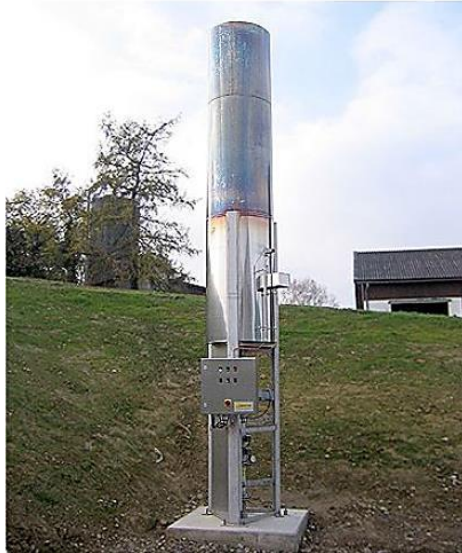
Εικόνα 5.14.: Πυρσός καύσης περίσσειας βιοαερίου
