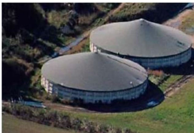
Εικόνα 5.12.: Δεξαμενές αποθήκευσης καλυμμένες με μεμβράνες
