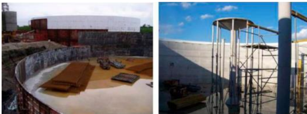
Εικόνα 5.7.: Επίτόπου κατασκευή κατακόρυφου χωνευτήρα από σκυρόδεμα
