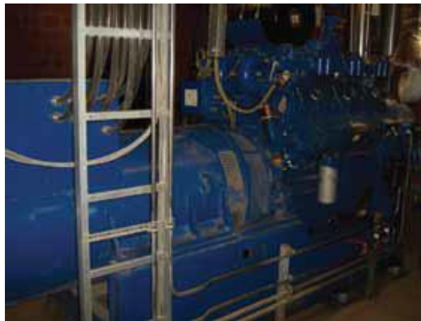
Εικόνα 4.2.: Μηχανές αερίου Otto
