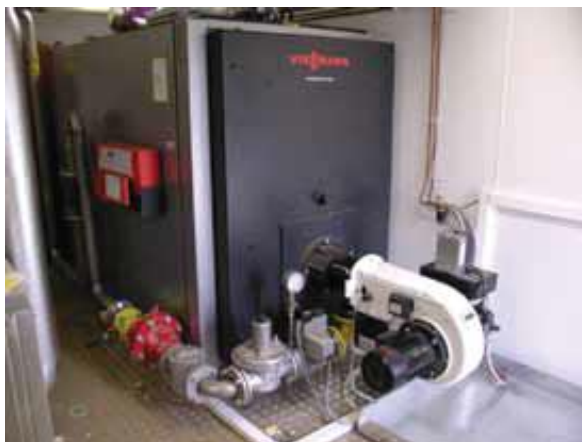
Εικόνα 4.1.: Καυστήρας βιοαερίου για την παραγωγή θερμότητας
