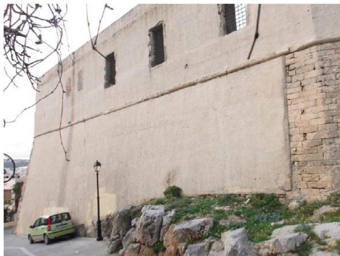
Φωτογραφία 2: Άποψη του κτιρίου του Μουσείου στην οποία διακρίνεται η θεμελίωσή του επί των ασβεστόλιθων του υποβάθρου.
