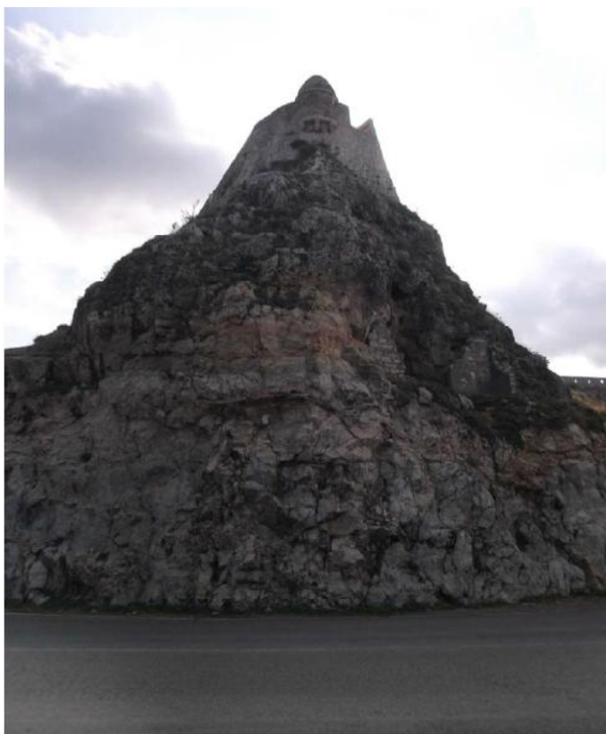
Φωτογραφία 1: Πρανές, επί του παραλιακού περιφερειακού δρόμου του Φρουρίου, στο οποίο διακρίνονται οι τεφροί ασβεστόλιθοι του υποβάθρου να καταλαμβάνουν το μισό κάτω τμήμα του πρανούς και οι ωχροί μαργαϊκοί ασβεστόλιθοι του Νεογενούς στα ανώτερα τμήματά του (ΘΑΛΗΣ, 2014).
