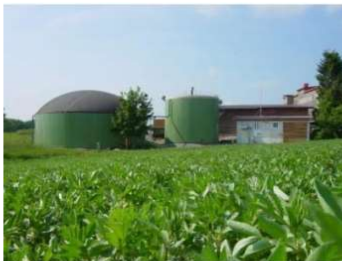
Εικόνα 3.3: Εγκατάσταση βιοαερίου στη Γερμανία, που επεξεργάζεται κοπριές από χοίρους, πουλερικά και σωρούς χόρτων ( 22)
