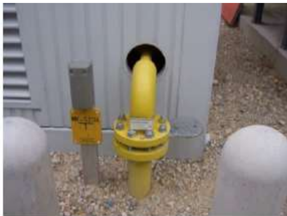
Εικόνα 4.10: Σύνδεση αγωγού με το δίκτυο του φυσικού αερίου
