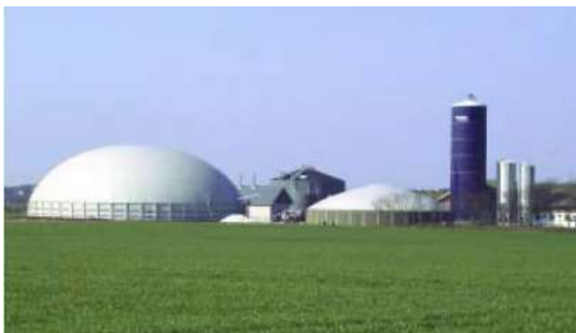
Εικόνα 3.2: Εγκατάσταση βιοαερίου κλίμακας αγροκτήματος στη Δανία, για συγχώνευση ζωικών πολτών και ενεργειακών καλλιεργειών (groengas.nl)
