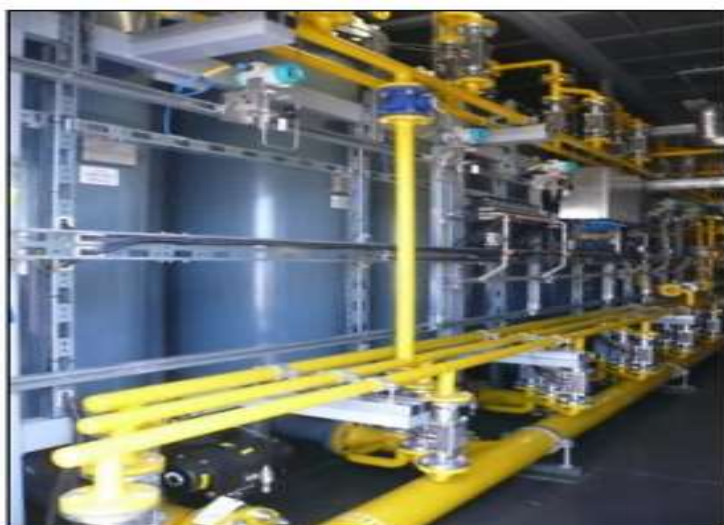
Εικόνα 4.4: Μονάδα διαχωρισμού \text{CH}_4 / \text{CO}_2 μέσω προσρόφησης με εναλλαγή πίεσης έξι δοχείων (Severn Wye Energy Agency)
