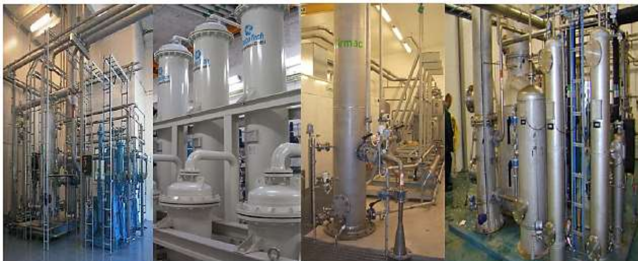
Εικόνα 4.7: Μονάδες αναβάθμισης βιοαερίου με απορρόφηση Selexol στη Σουηδία (Jonsson O. 2008)
