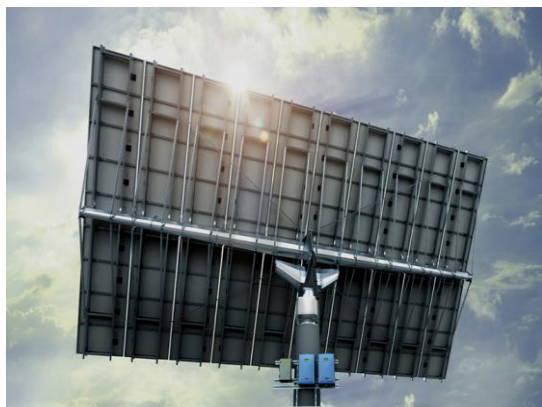
Εικόνα 1 Βάση στήριξης Φ/Β με πάνελ
