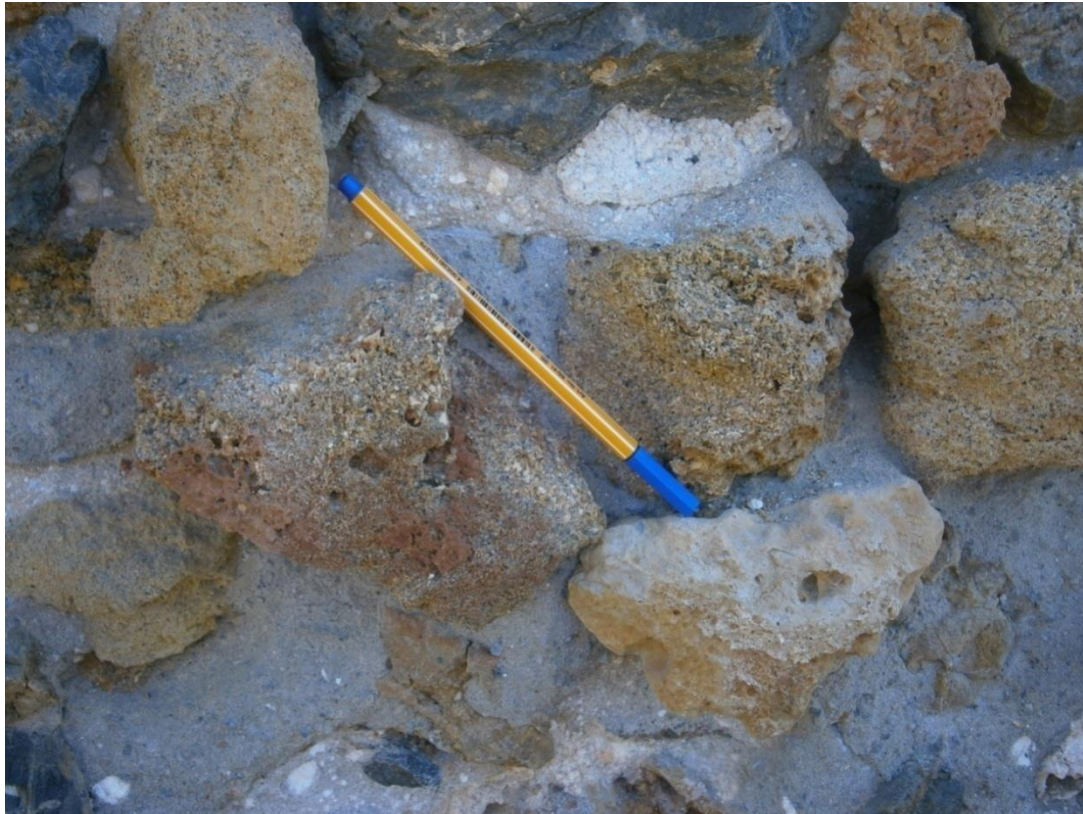
Εικόνα 5-1. Δομές tafoni σε δομικούς λίθους του Φραγκοκάστελλου.
