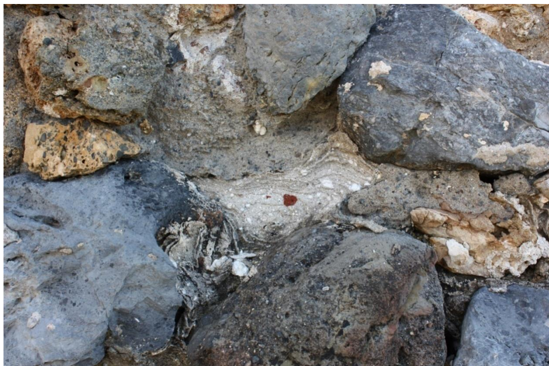
Εικόνα 5-2. Δομές tafoni σε συνδετικό κονίαμα του Φραγκοκάστελλου.
