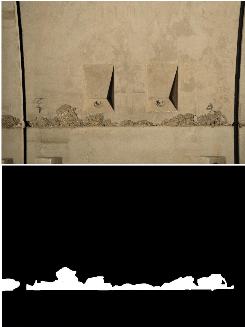
Εικόνα 3.1 : Παράδειγμα της φωτογραφίας 31 από τις 37 που αντιμετωπίζει ελάττωμα θρυμματισμού μαζί με την annotation εικόνα της.
