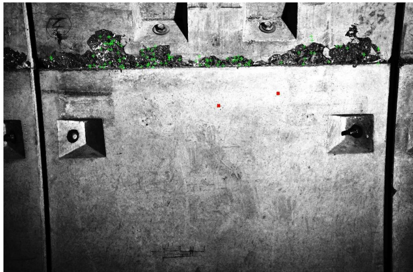
Εικόνα 3.15 : Η καλύτερη φωτογραφία θρυμματισμών για τον Shi-Tomasi(MinEigen) είναι η 30 και έχει πολλές φορές Precision 100%. Εδώ βλέπουμε όταν έχει 98% Precision στα 100 σημεία ανίχνευσης. Αστοχούν μόνο οι 2 κόκκινοι σταυροί.
