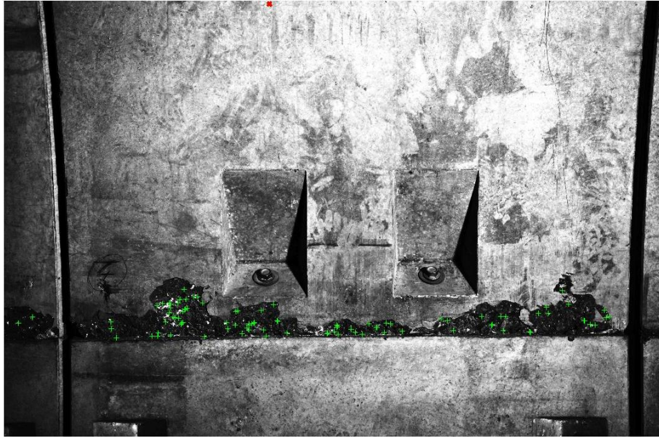
Εικόνα 3.19 : Η καλύτερη φωτογραφία θρυμματισμών για τον FAST είναι η 31 και έχει πολλές φορές Precision 100%. Εδώ βλέπουμε όταν έχει 99% Precision στα 100 σημεία ανίχνευσης. Αστοχούν μόνο ένα σημείο(κόκκινος σταυρός) στο πάνω μέρος της φωτογραφίας.
