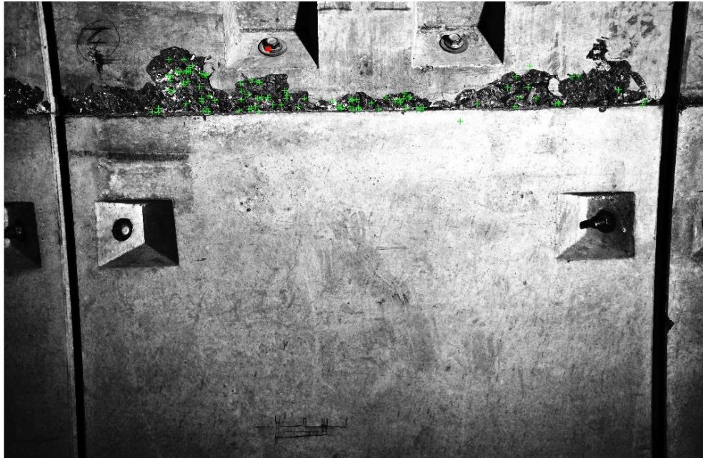
Εικόνα 3.11 : Η καλύτερη φωτογραφία θρυμματισμών για τον Harris είναι η 30 και έχει πολλές φορές Precision 100%. Εδώ βλέπουμε όταν έχει 99% Precision στα 100 σημεία ανίχνευσης. Αστοχεί μόνο ο κόκκινος σταυρός.
