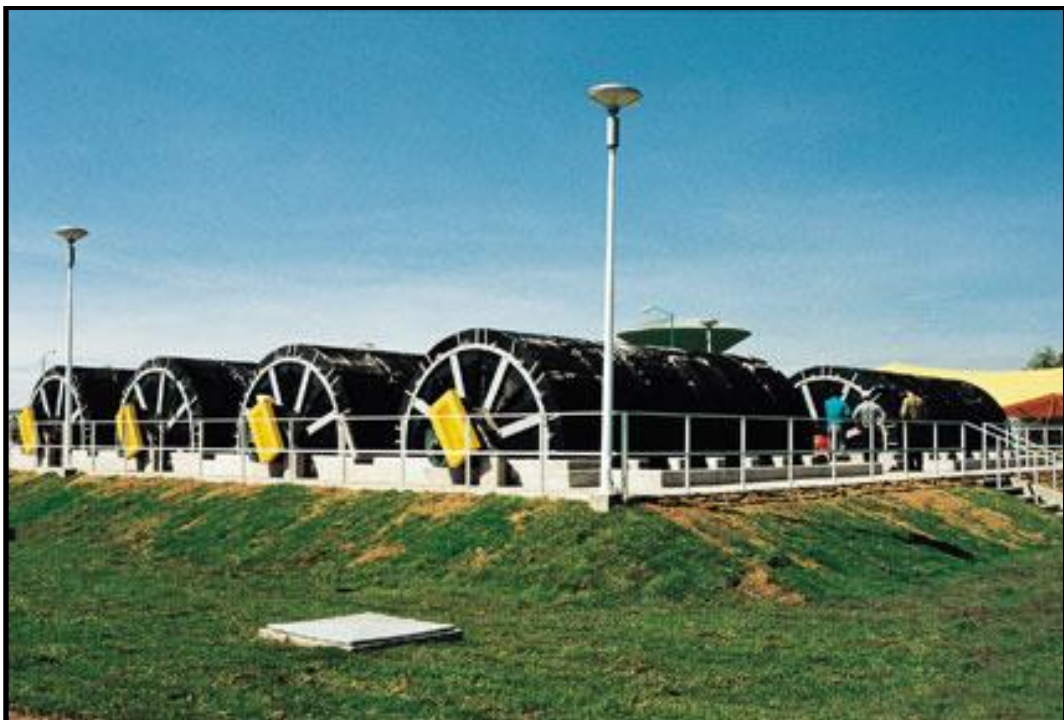
Εικόνα 3.2: Περιστρεφόμενοι βιολογικοί δίσκοι σε ανοιχτό χώρο
