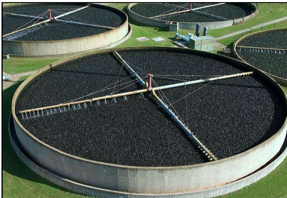
Εικόνα 3.1: Δεξαμενή φίλτρων προσκολλημένης βιομάζας σταθερής κλίνης
