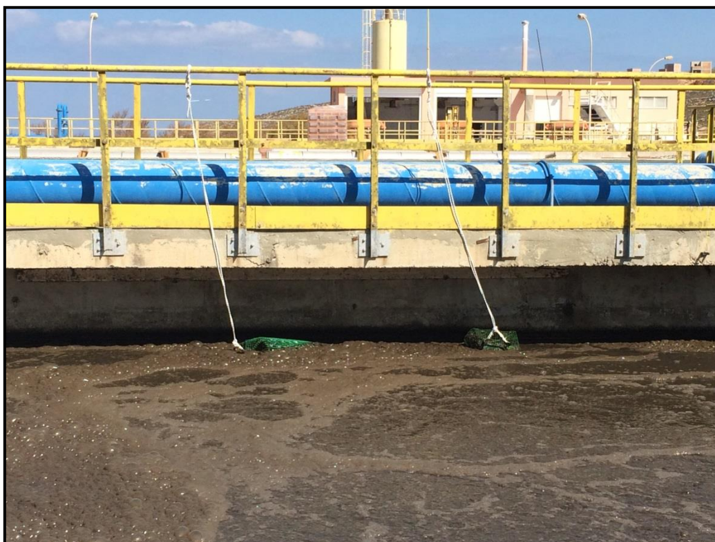
Εικόνα 4.10: Τοποθέτηση των πληρωτικών υλικών στη δεξαμενή αερισμού της μονάδας βιολογικού καθαρισμού Δήμου Χανίων.
