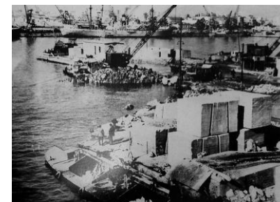
103. Κατασκευή κρηπιδωμάτων επί Επιτροπείας, 1924-1931
