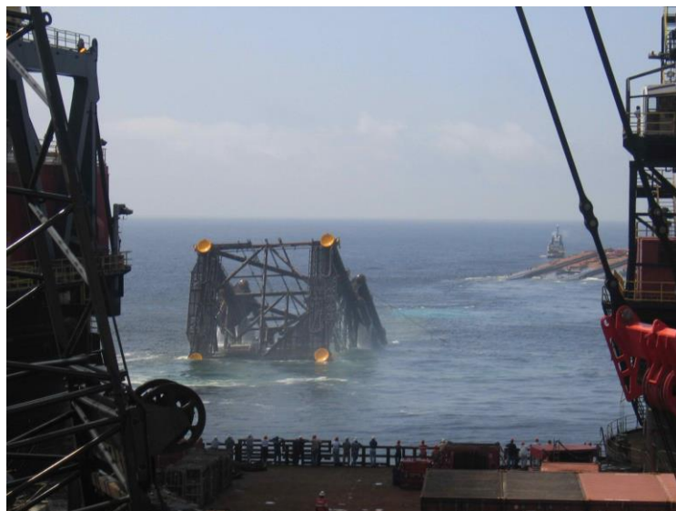
Εικόνες #4, 5. Ισορρόπηση του τμήματος στην θέση του. Πηγή Wikipedia.
