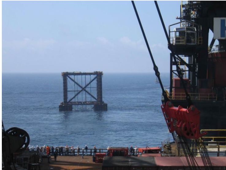
Εικόνα #6. Το τμήμα της εξέδρας είναι έτοιμο να δεχθεί το επόμενο τμήμα για την συνέχεια της κατασκευής. Πηγή Wikipedia.
