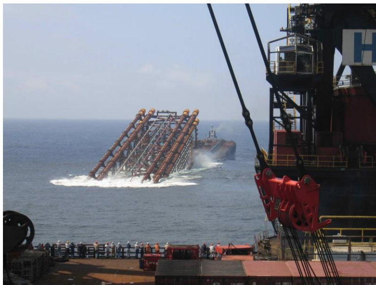
Εικόνα #3. Απόθεση από την φορτηγίδα του τμήματος της εξέδρας. Πηγή Wikipedia.
