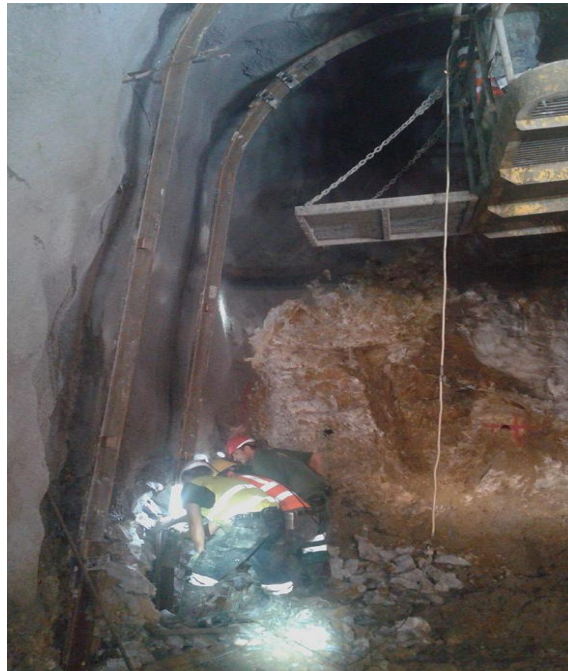
Σχήμα 38. Εργασίες υποστήριξης πλαισίων μεταλλείου Ολυμπιάδας
