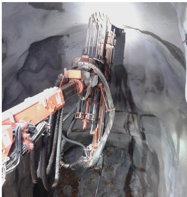
Σχήμα 36. Κοχλίωση οροφής μεταλλείου Ολυμπιάδας
