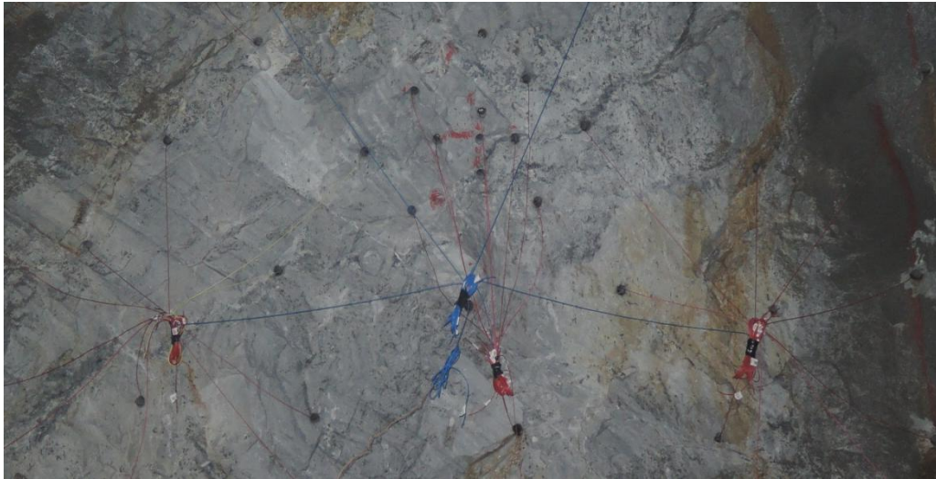
Σχήμα 34. Συνδεσμολογία εκρηκτικών στο μέτωπο
