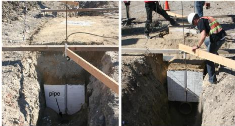
Σχήμα 5.6 Τοποθέτηση γεωαφρού EPS ως υλικού επίχωσης αγωγού [Bartlett et al., 2014].
