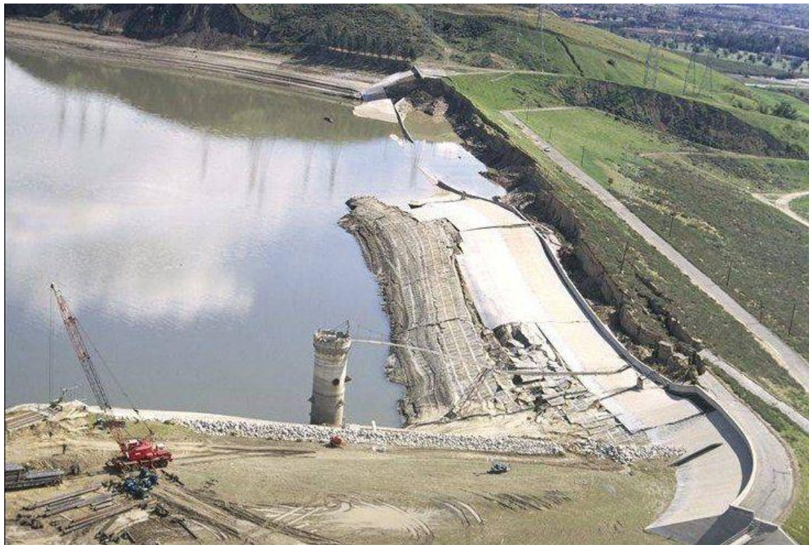
Σχήμα 3.7 Αστοχία του φράγματος Lower στο San Fernando έπειτα από τον σεισμό του 1971 [Πιτιλάκης 2010].
