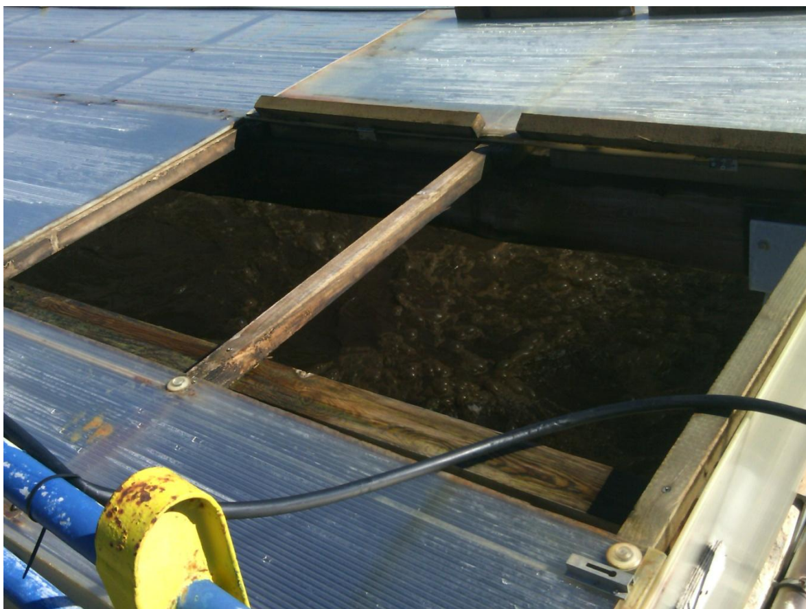
Εικόνα 3: Άνοιγμα στην επιφάνεια του Χωνευτή 2
