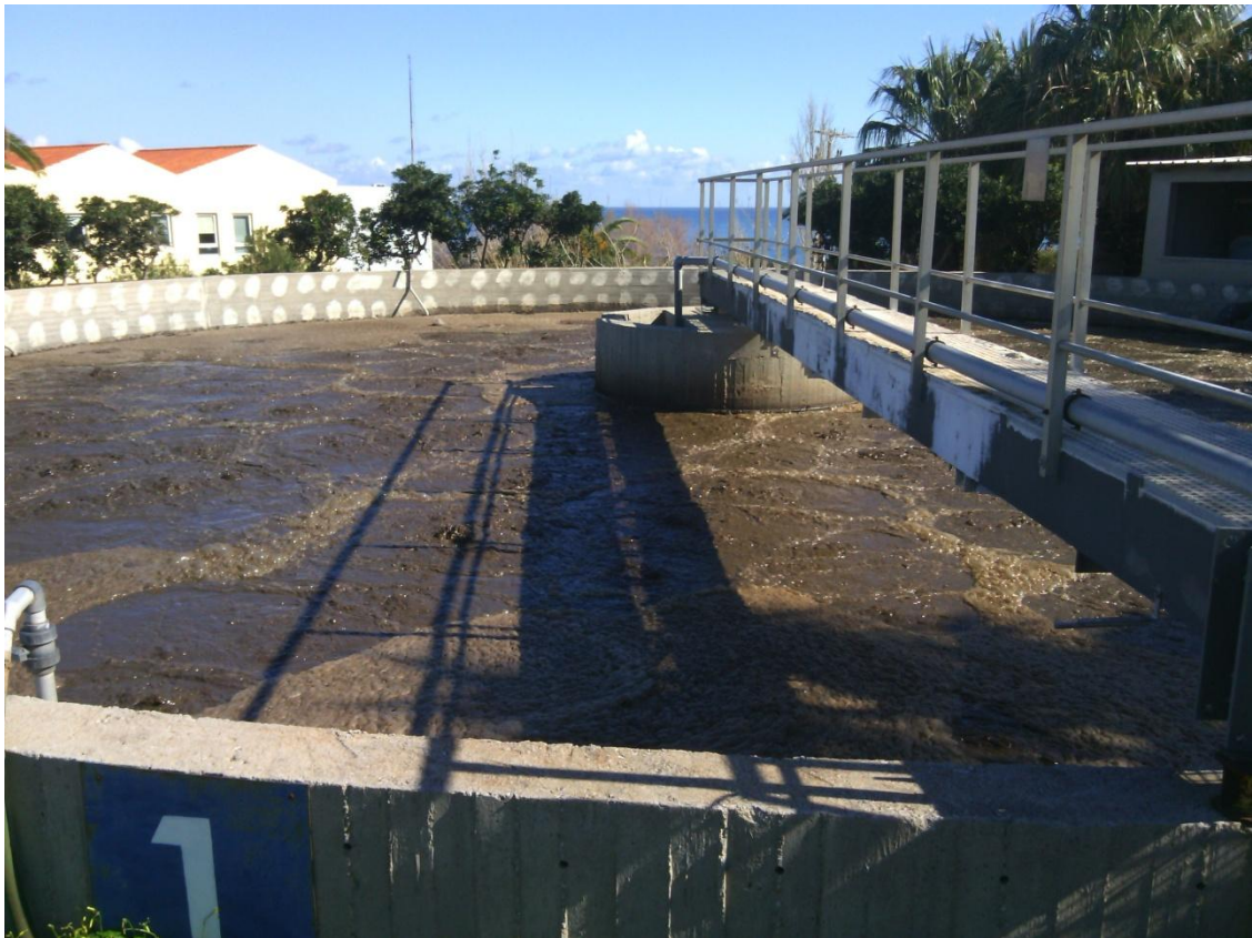
Εικόνα 4: Αποψη Αερόβιου Χωνευτή 1 (πρώην ΔΠΚ)
