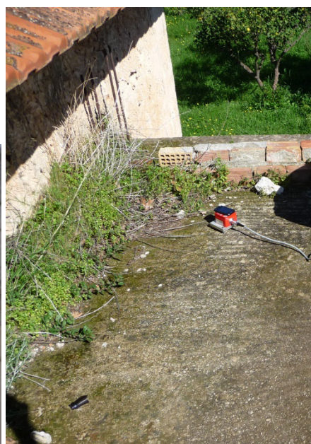
Εικόνα 3.7: Η αποσάθρωση του σκυροδέματος και η υγρασία είναι εμφανής σε ολόκληρη την επιφάνεια της πλάκας.
