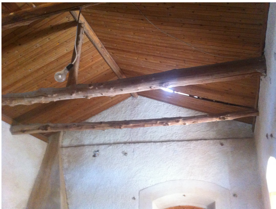
Εικόνα 3.8: Διάρρηξη της στέγης που επιτρέπει στα νερά της βροχής να εισέρχονται στο εσωτερικό.
