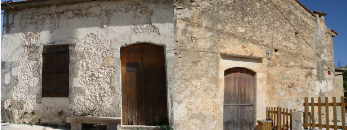
Εικόνα 3.2: Στην ανατολική όψη (αριστερά) φαίνεται καθαρά η αποκόλληση του επιχρίσματος στο πάνω μέρος της όψης ενώ στη βόρεια όψη (δεξιά) παρατηρούνται διάσπαρτα μικρά κενά που προκλήθηκαν από πτώσεις λίθων.
