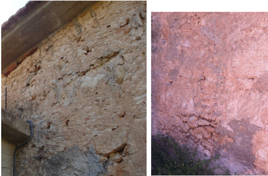
Εικόνα 3.4: Κυψελοποίηση τμήματος λιθοδομής στο δυτικό τμήμα.
