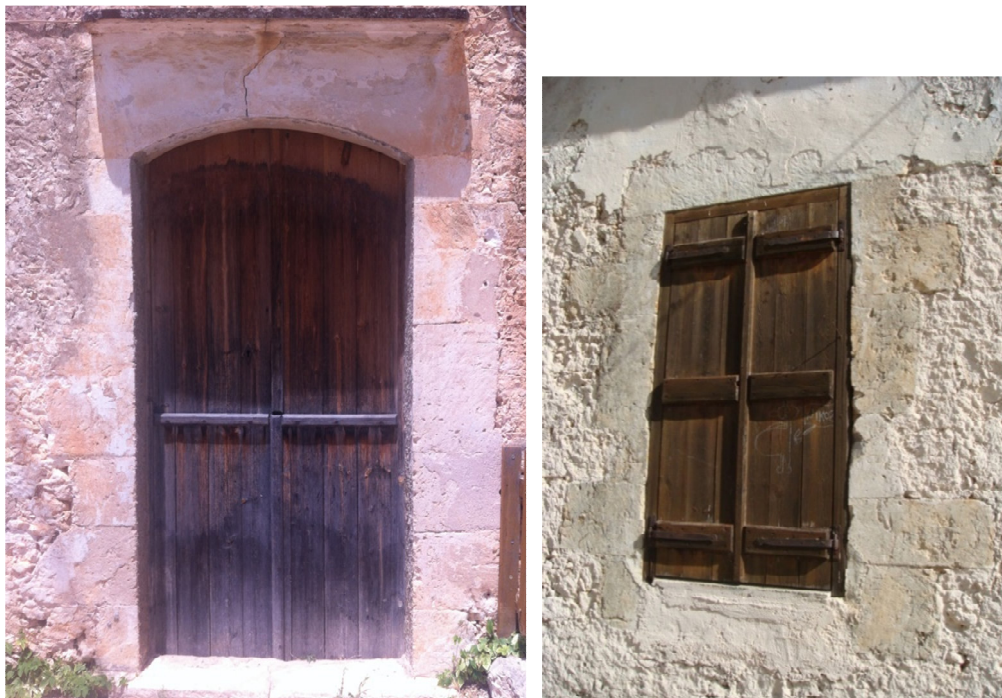
Εικόνα 2.15: Λίθινα πρέκια ανοιγμάτων.
