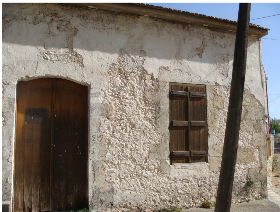
Εικόνα 2.12: Ανοίγματα όπου διακρίνονται οι λαξευμένοι λίθοι που αποτελούν τις περιμέτρους τους καθώς και τα αγκωνάρια στην ακμή του κτιρίου.
