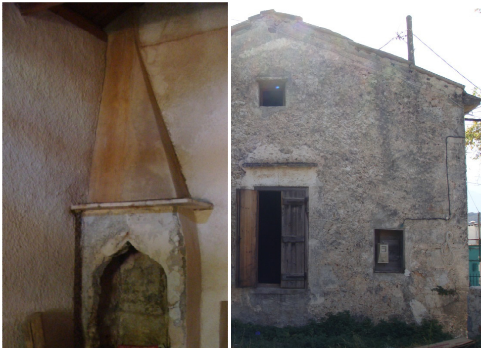
Εικόνα 3.3: Η κατερχόμενη υγρασία έχει κάνει εμφανή την παρουσία της τόσο στο εσωτερικό του κτιρίου (καμινάδα) όσο και στις εξωτερικές επιφάνειες των τοίχων.
