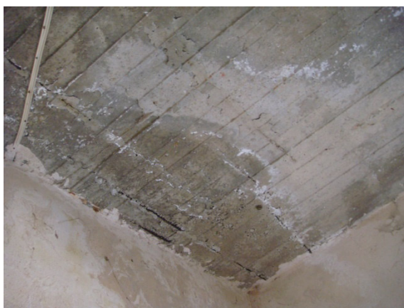
Εικόνα 3.7: Η αποσάθρωση του σκυροδέματος και η υγρασία είναι εμφανής σε ολόκληρη την επιφάνεια της πλάκας.
