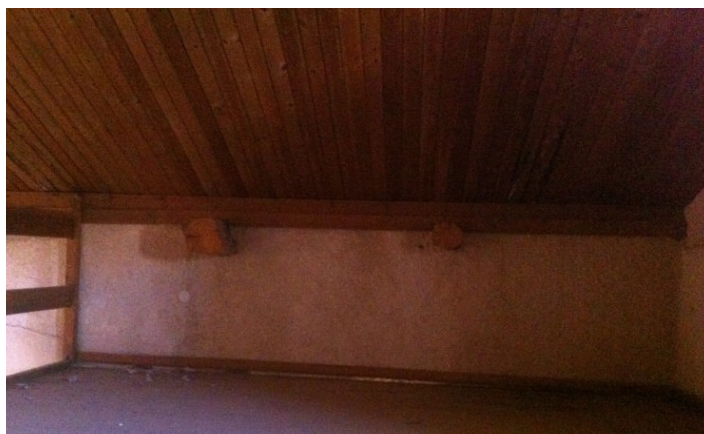
Εικόνα 2.20: Οι δοκοί που κόπηκαν για να κατασκευαστεί το πατάρι.
