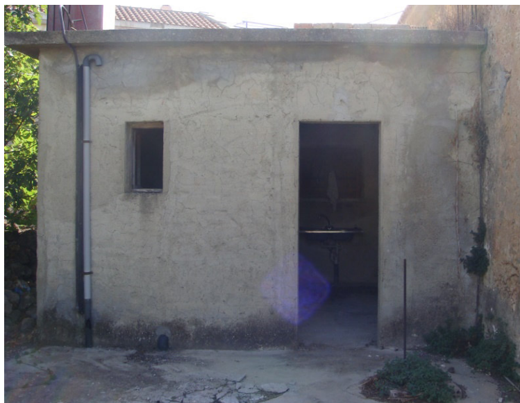
Εικόνα 3.6: Εμφανείς σε όλη την επιφάνεια του τοίχου οι τριχοειδείς ρωγμές καθώς και η κατερχόμενη υγρασία στη στέψη της αποθήκης.
