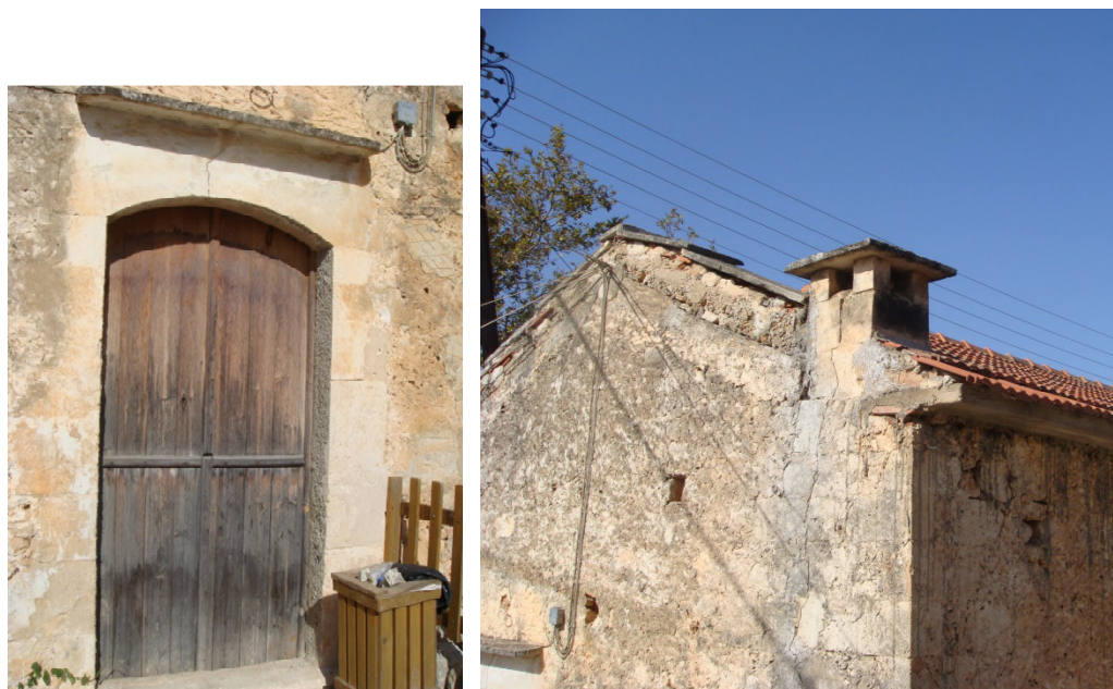
Εικόνα 3.1: Αριστερά φαίνεται η κατακόρυφη ρωγμή στο ανώφλι της πόρτας στη βόρεια όψη ενώ δεξιά φωτογραφίζεται η βορειο-δυτική γωνία της λιθοδομής με τις κατακόρυφες ρωγμές να επηρεάζουν τη δυσκαμψία των δύο τοίχων.
