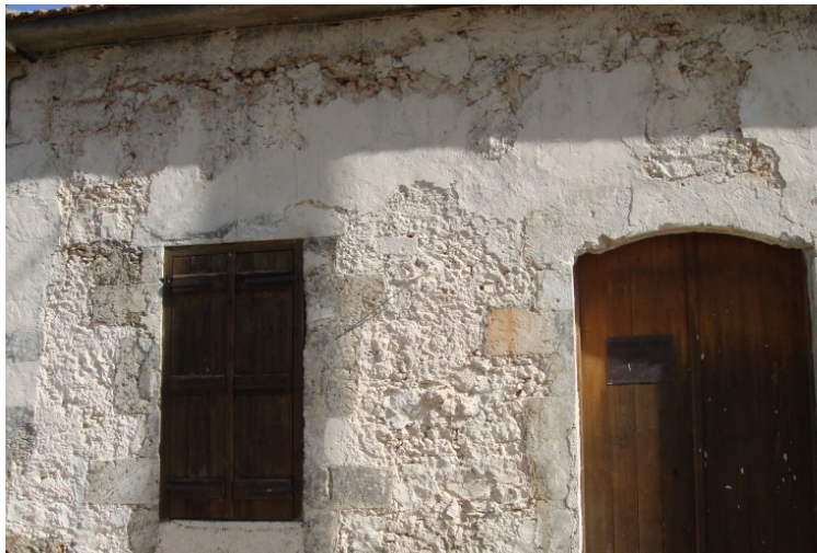
Εικόνες 3.5: Σημεία κυψελοποίησης της λιθοδομής στην ανατολική όψη.
