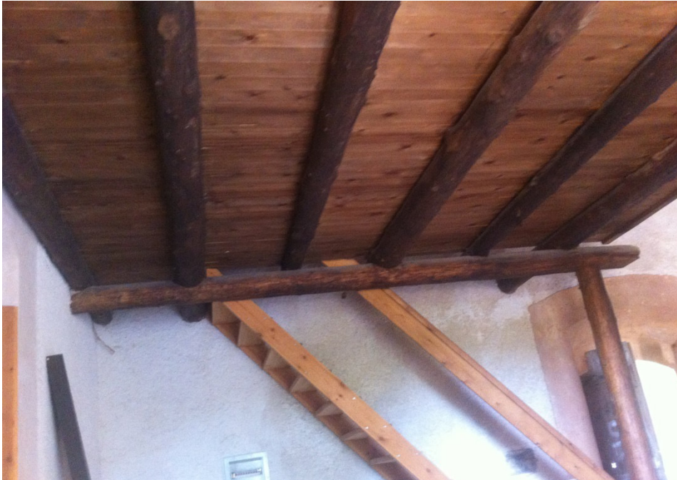
Εικόνα 2.19: Φωτογραφία του παταριού από το ισόγειο όπου διαφαίνονται οι 5 ξύλινες δοκοί, τρεις εκ των οποίων εγκιβωτίζονται στον τοίχο.
